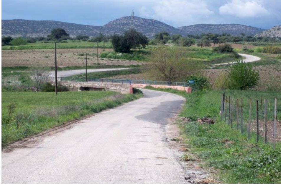
Köyün girişi ve yakın zamanda yapılan köprü.
