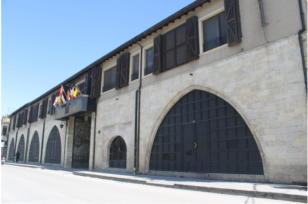
Foto 3.20. Kurtuluş Caddesi'nde yer alan Antakya Savon Otelden bir görünüm
