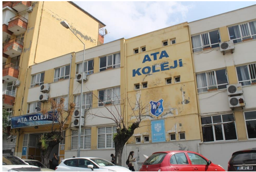
Foto 3.16. Asi Nehri'nin doğu yakasında Kışlasaray Mahallesi'nde Antakya Ata Koleji
