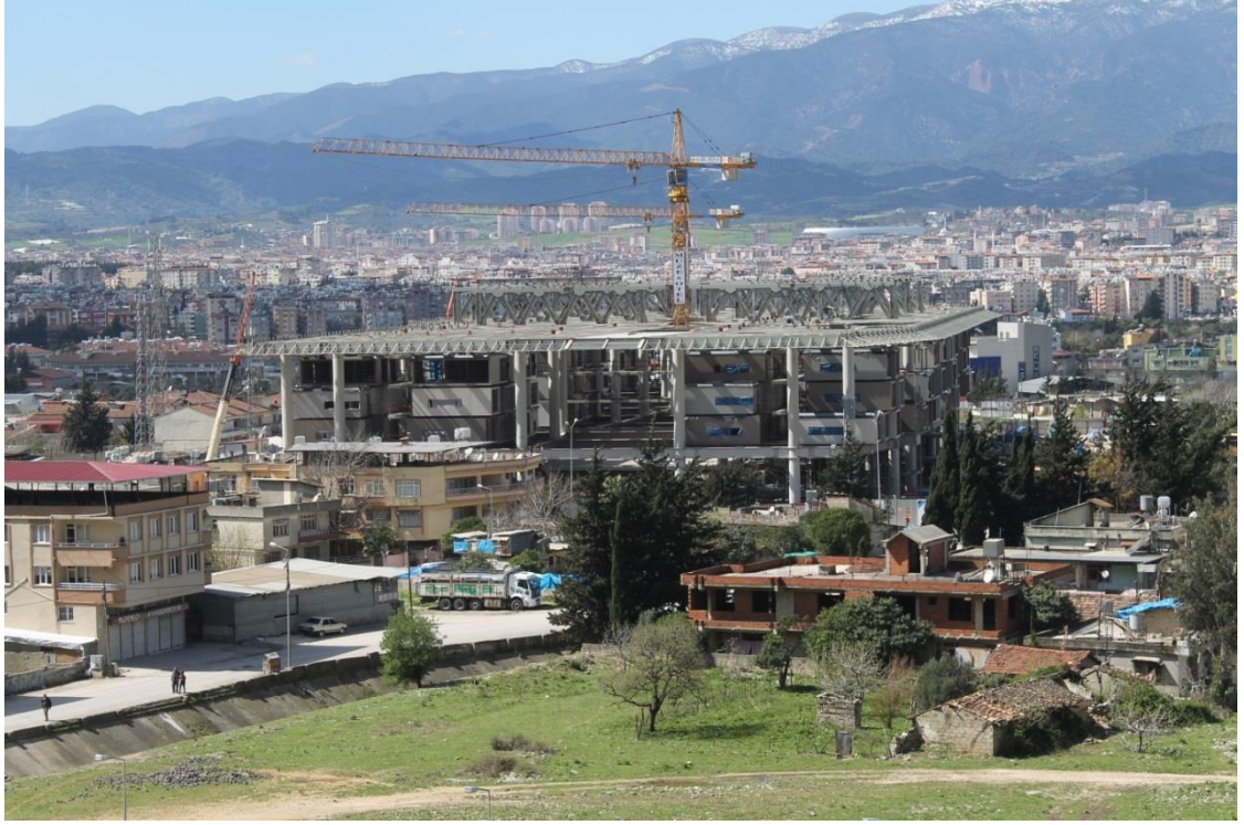
Foto 3.29. Haraparası Mahallesi'nde yer alan ve henüz yapım aşamasında olan Hilton Antakya Müze Otelden bir görünüm.
