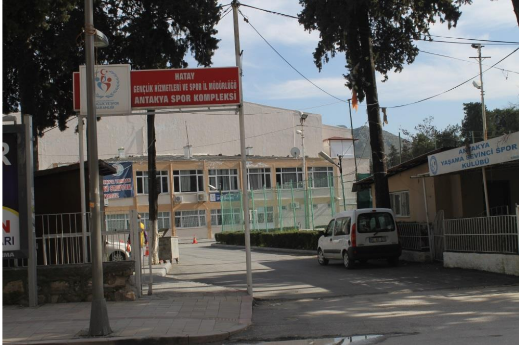
Foto 3.8. Cumhuriyet Mahallesi'nde yer alan Antakya Kapalı Spor Salonu
