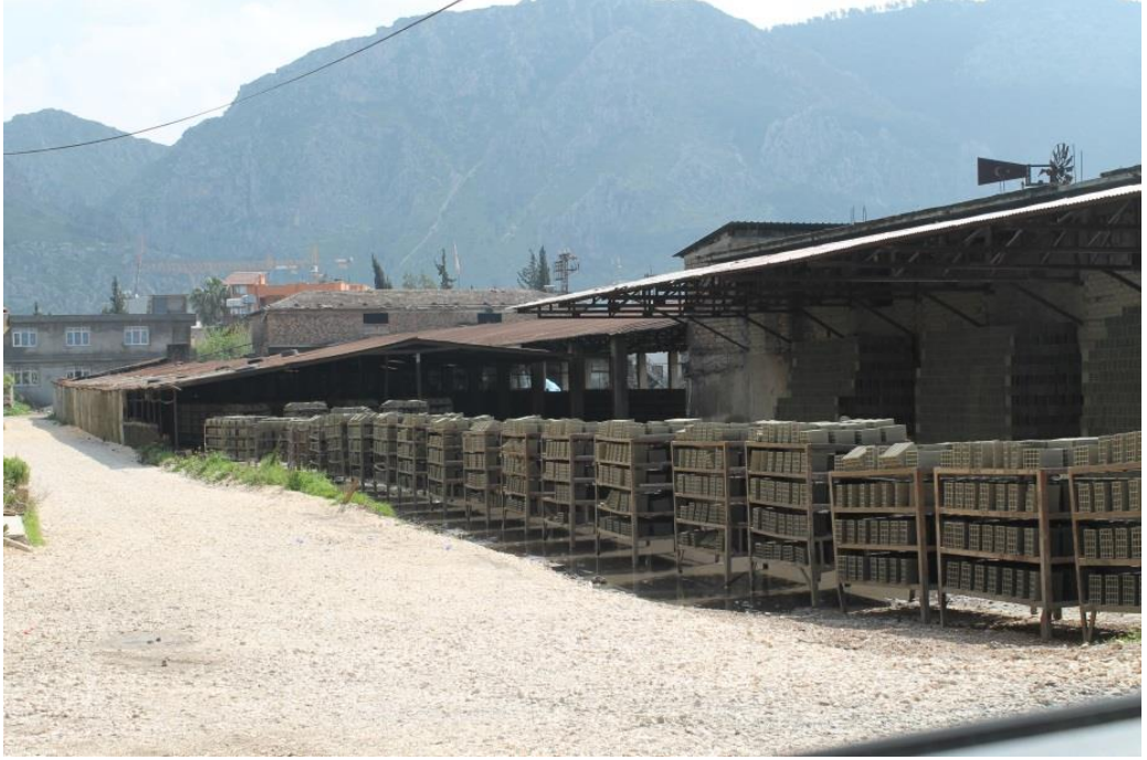
Foto 3.25. Küçükdalyan Mahallesi'nin girişinde yer alan Asfuroğlu Tuğla Fabrikası
