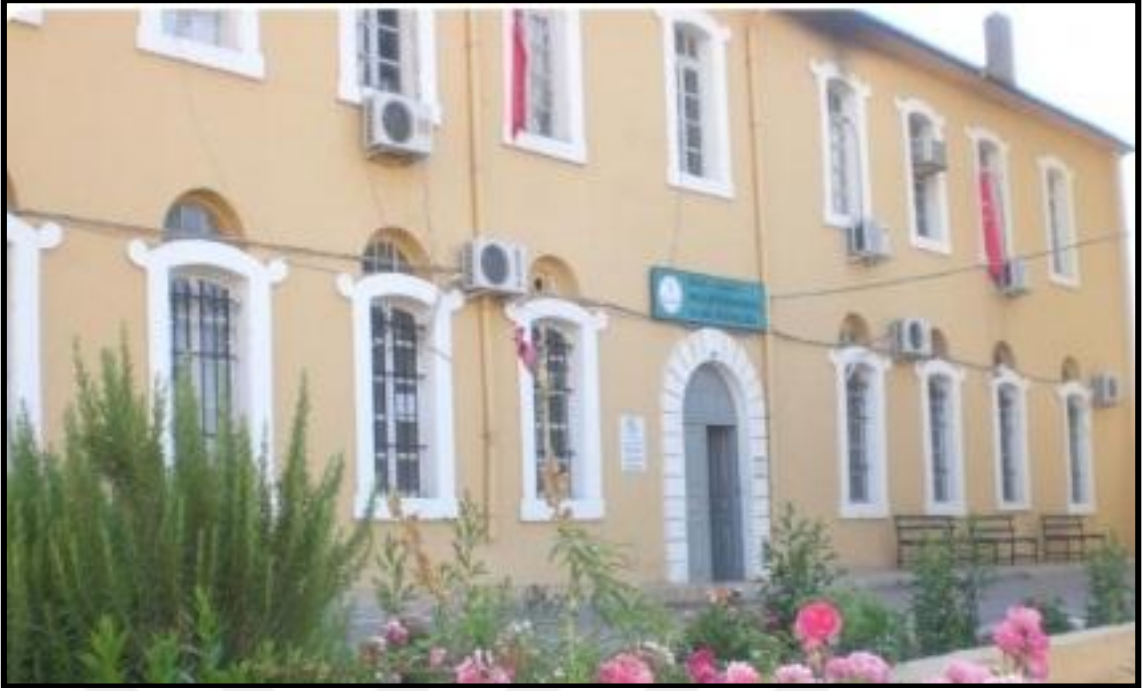
Foto: 3.7. Tarihi Yapıtta Kurulu Halk Eğitim Binası.
