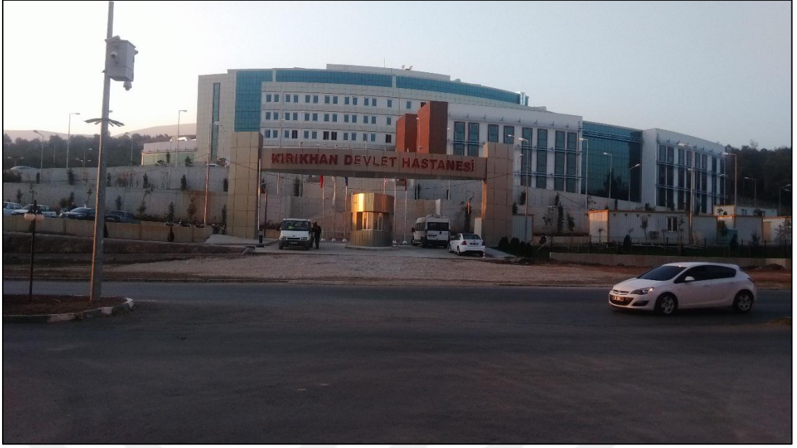
Foto: 3.9. 2015'te Yapımı Tamamlanacak Olan Yeni Devlet Hastanesi.
