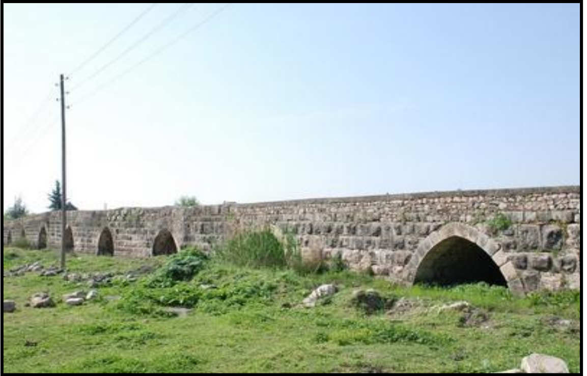
Foto 4.15. Muratpaşa Köprüleri (Muratpaşa Köyü)
