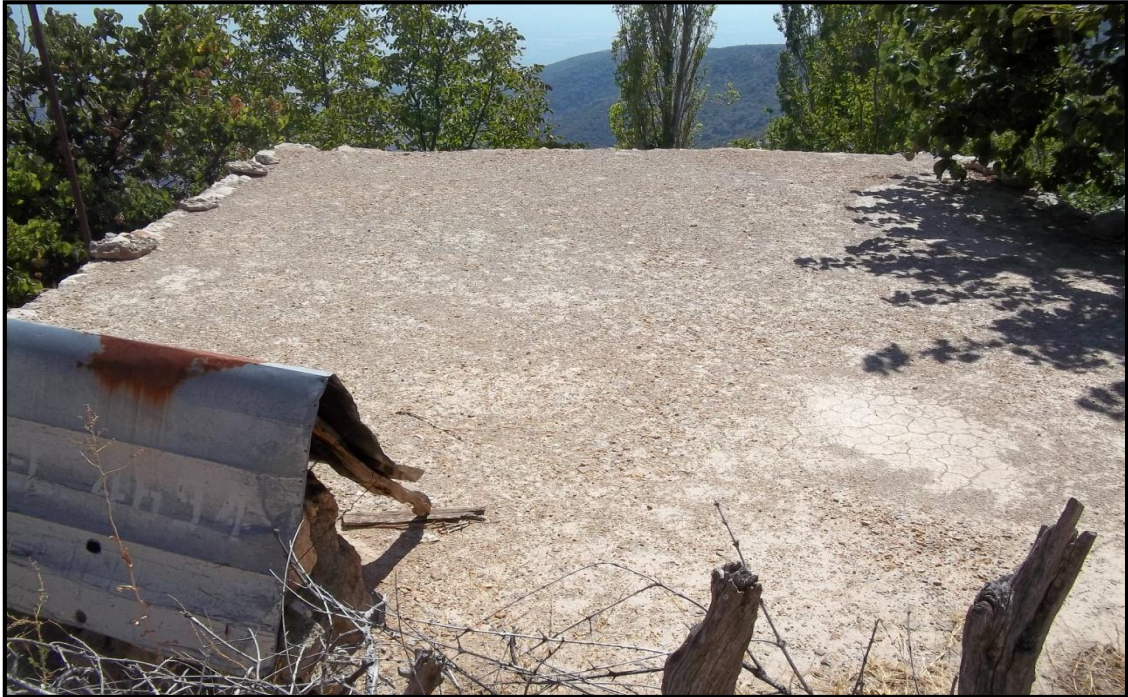
Foto: 3.13. Düz dam kerpiç evler (Arkatça Köyü)
