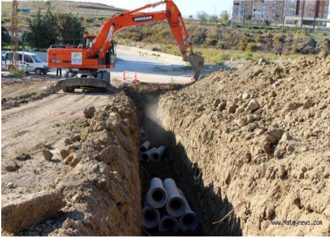
Foto 4- Antakya İlçesi'nde Su Şebekesi iyileştirme Amaçlı Yapılan Altyapı Çalışmaları
