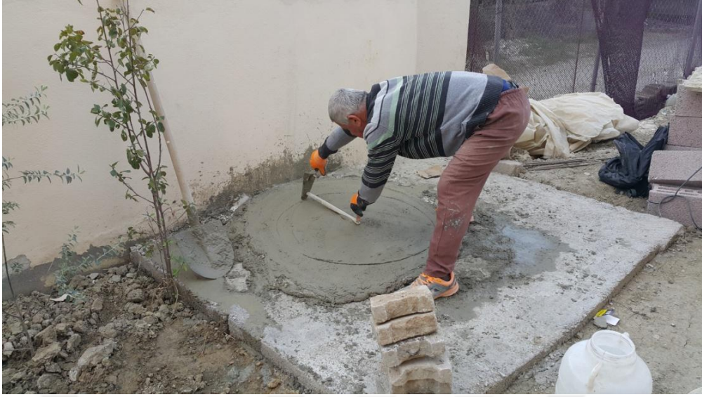
Foto 53: Tandır zeminine Şekilleneceği Dairenin Çizilmesi.
