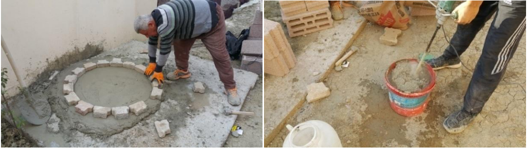
Foto 54: Kilit Taşlarının Dizilmesi
