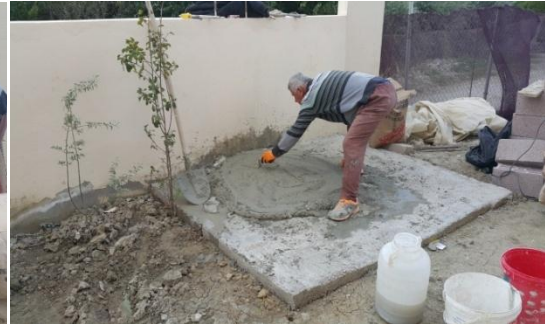
Foto 52: Tandır Zeminin Hazırlanması.
