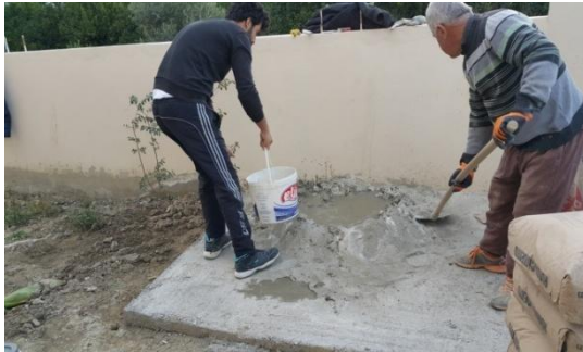
Foto 51: Zemin Harcının Hazırlanması
