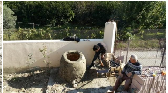
Foto 66: Tandırın Harç İle Kaplanması.
