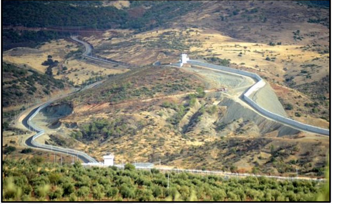
Fotoğraf 14: Türkiye (Hatay) Suriye Sınırı Duvar İnşası
