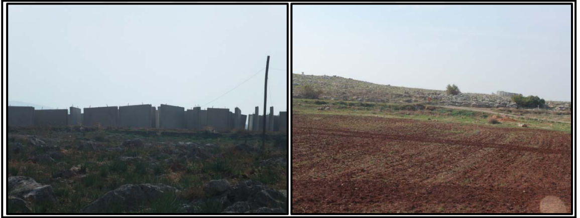
Foto 2.7. Yapımı devam güvenlik duvarları
