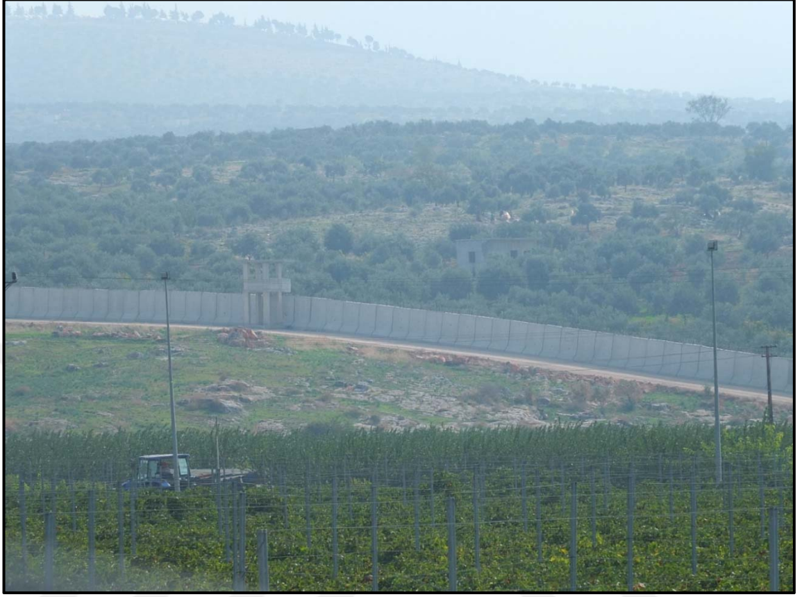
Foto 2.5. Türkiye-Suriye sınırındaki örülen güvenlik duvarı ve akıllı kuleler, (Reyhanlı-Cilvegözü Yolu, 12.11.2016)
