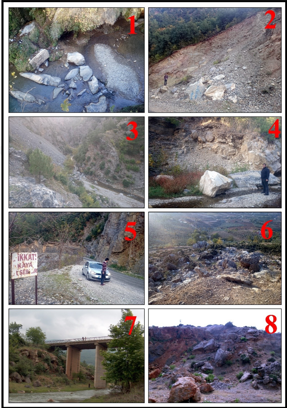
Foto 72: Araştırma Alanındaki Kaya Düşmeleri ve Tehlike Alanları.
