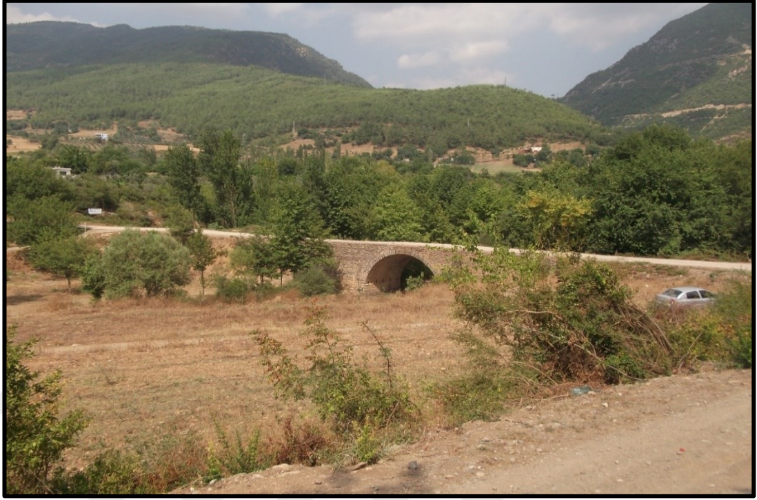
Foto 56: Çatak Boğazı ve Tarihi Taş Köprü.
