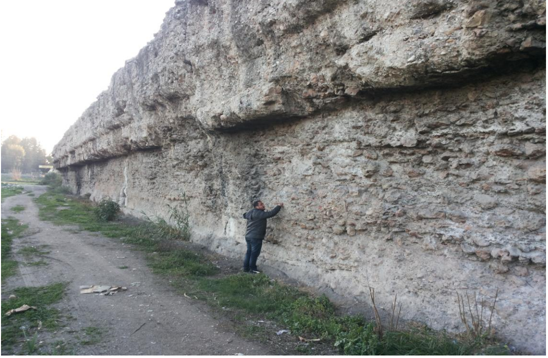
Fotoğraf 22: Donuktaş Çevre Duvarı.
