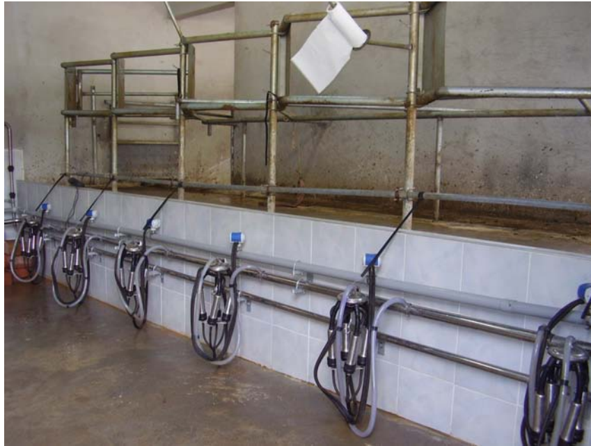
Şekil 4.3. Edirne İli 3 No'lu tesisin genel görünümü
