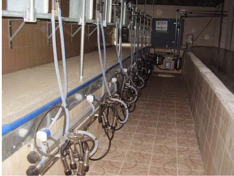
Şekil 4.6. Kırklareli İli 1 No'lu tesisin genel görünümü
