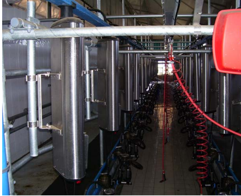
Şekil 4.1. Edirne İli 1 No'lu tesisin genel görünümü
