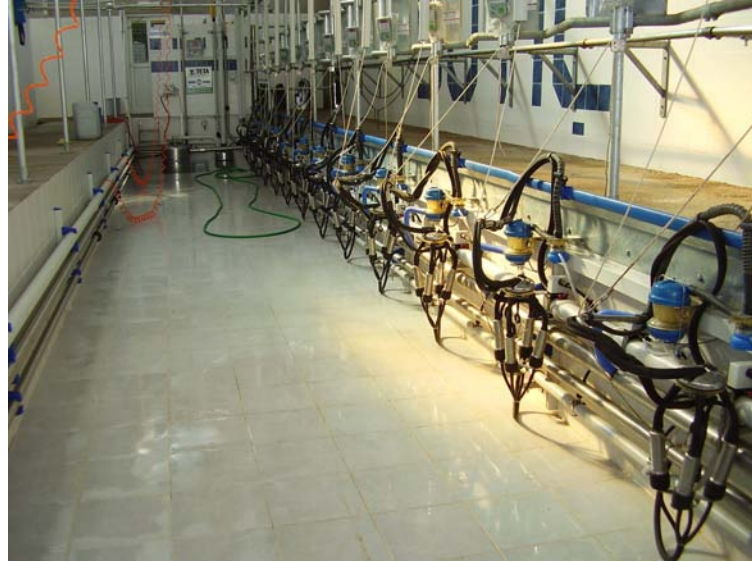
Şekil 4.8. Kırklareli İli 3 No'lu tesisin genel görünümü
