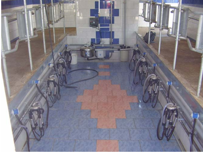
Şekil 4.2. Edirne İli 2 No'lu tesisin genel görünümü
