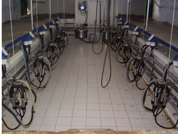
Şekil 4.12. Kırklareli İli 7 No'lu tesisin genel görünümü
