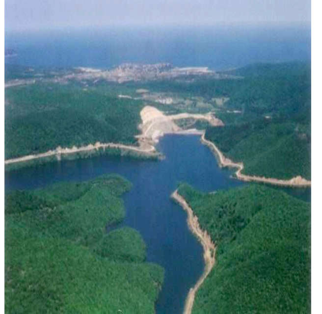
Şekil 4.7. İSKİ tarafından inşa edilen Kazandere barajı
