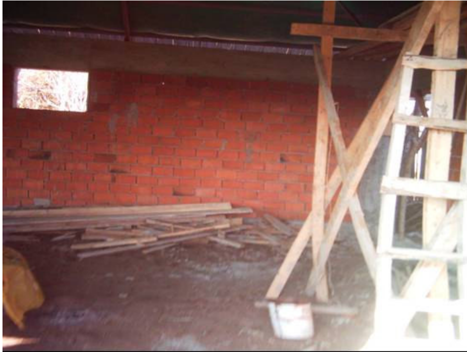
Şekil 5. Bolu yöresinde inşaat halindeki bir ağıl
