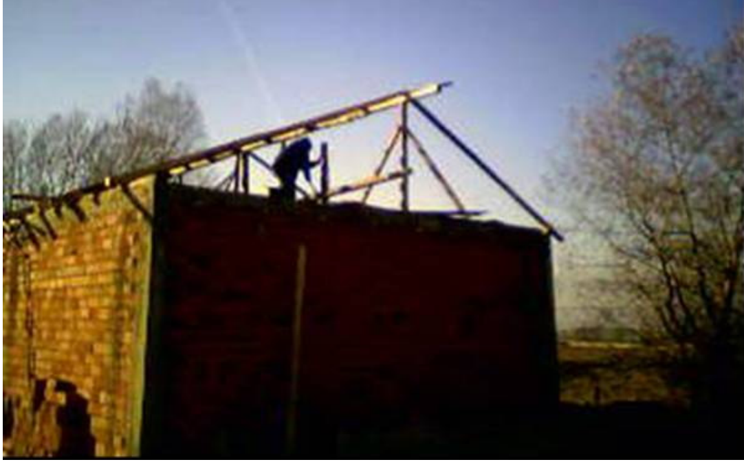
Şekil 19. Çaygökpınar köyündeki bir ağıl çatısının inşası
