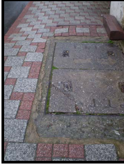
Şekil 4.2.c Şaşkın Bakkal olumsuz döşeme elemanı örneği [Özgün]
