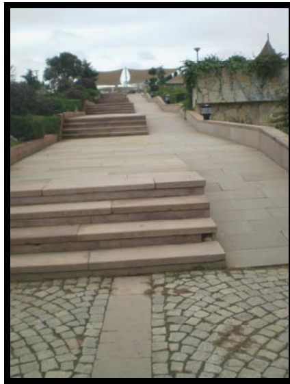
Şekil 4.16. Özgürlük Parkı rampa örneği [Özgün]
