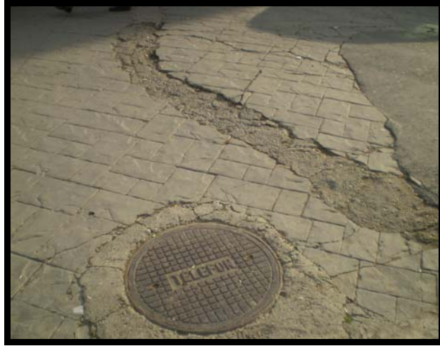
Şekil 4.4.a Eminönü olumsuz döşeme elemanı örneği [Özgün]
