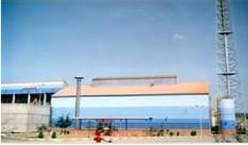
Şekil 2.2 Tıbbi Atık Yakma Tesisi, Odayeri, İSTAÇ
