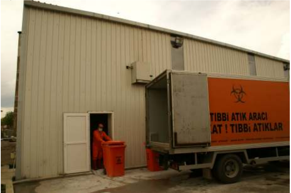
Şekil 3.5 Tıbbi Atık Sterilizasyon Tesisi, Atıkların Araçtan Geçici Atık Deposuna Boşaltılması, Edirne
