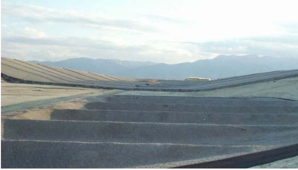
Şekil 2.3: Düzenli Depolama Sahası, Depolama Tabanı, Denizli [14]
