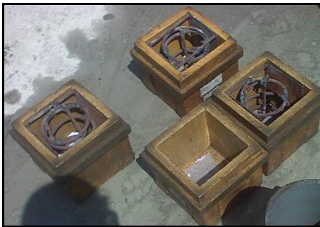
Resim 4.2.1. Spiral biçimindeki donatının kalıplara yerleştirilmesi
