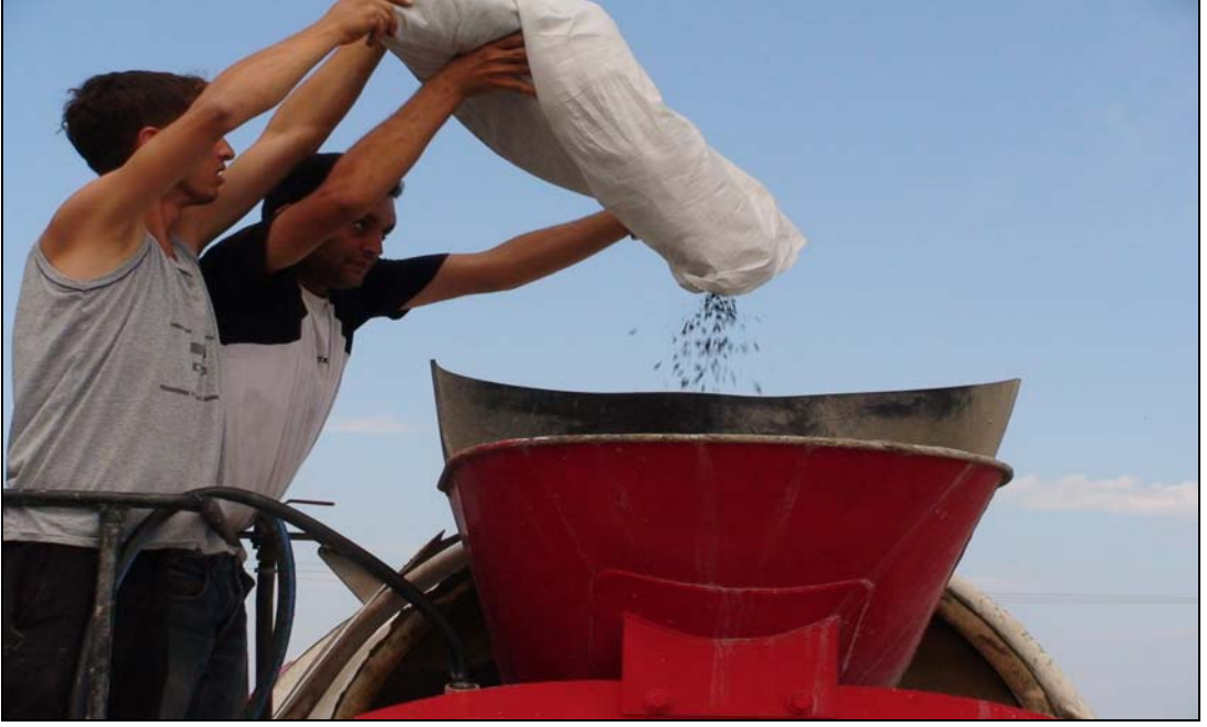
Şekil 20. Plastik'in betona katılması
