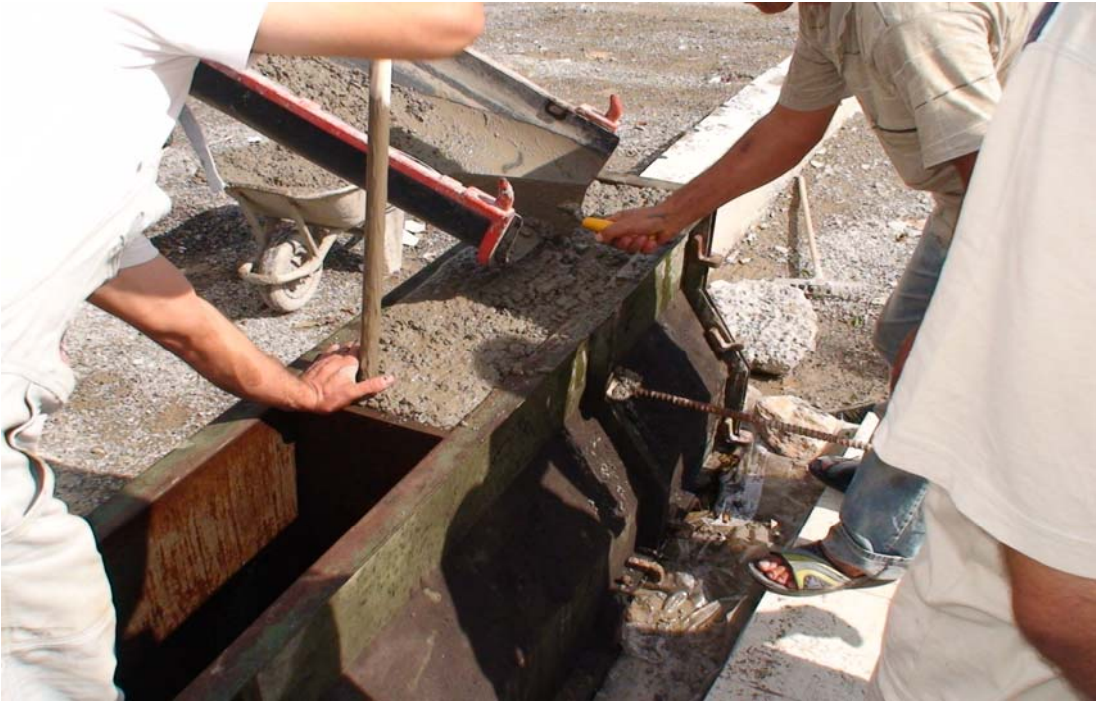
Şekil 21. Betonun kalıplara dökülmesi
