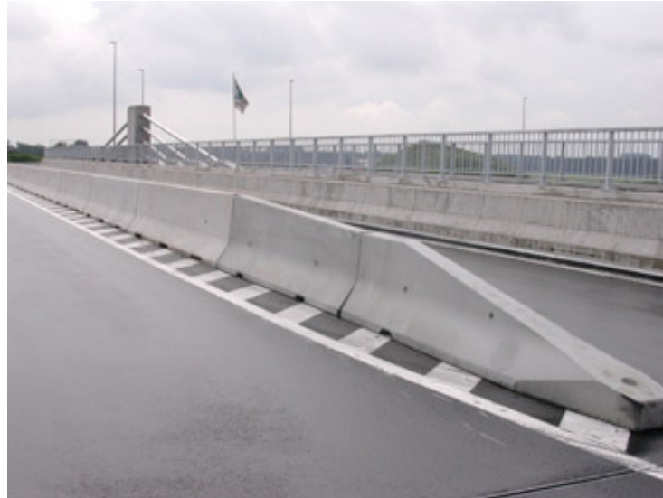
Şekil 17. Beton otoyol bariyerleri
