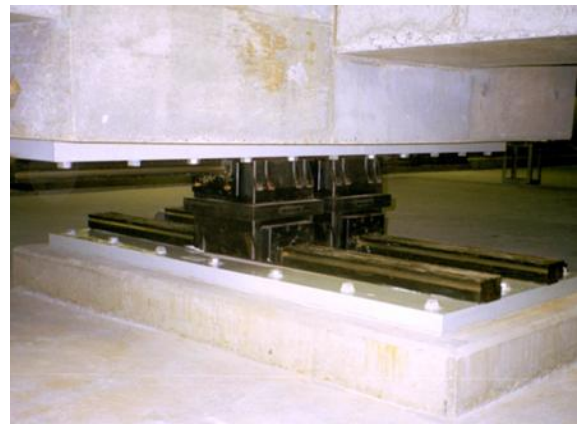
Şekil 3.25. Çapraz raylı izolatörlerin yapıya uygulanmış hali
