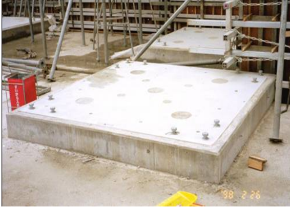
Şekil 3.16. Kauçuk tabakalı kayar mesnet alt plakasının radye temel üzerine yerleştirilmiş hali
