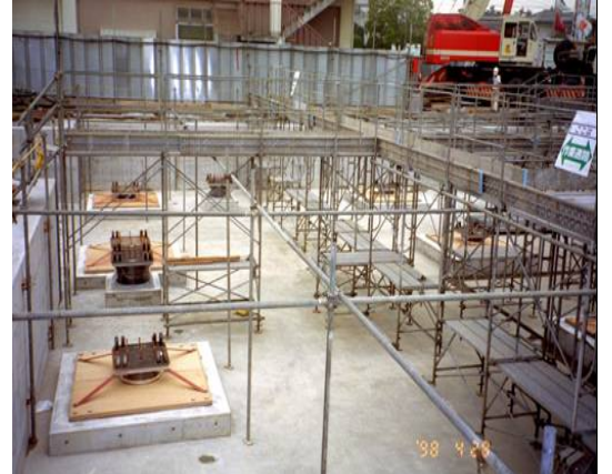
Şekil 3.19. Kayıcı mesnetlerin tamamı yerleştirilmiş ve üst yapı için hazırlıklar devam etmekte
