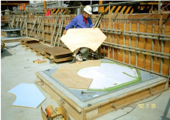
Şekil 3.17. Kauçuk tabakalı kayar mesnedin yerleşeceği kısmın düzenlenmesi
