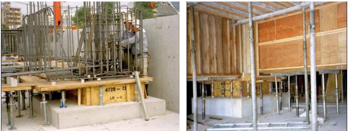
Şekil 3.8. Üst yapı kolon ve kirişlerinin donatılarının yerleşimi ve kalıplarının hazırlanması
