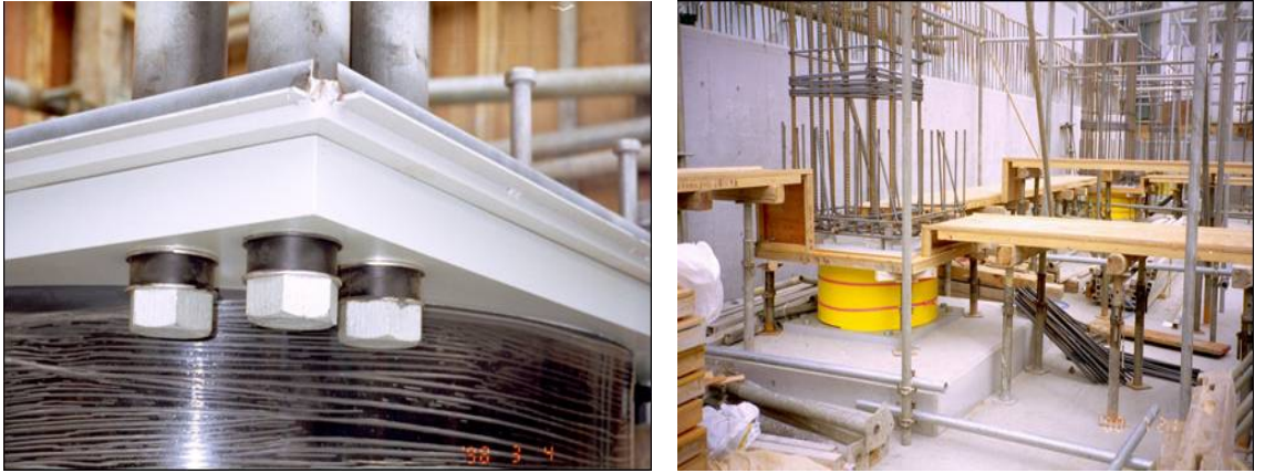
Şekil 3.7. İzolator aşaması tamamlanmış ve üst yapıya geçmek için izolator seviyesinde kalıpların hazırlanma aşaması
