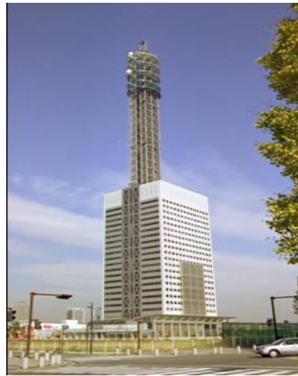
Şekil 3.21. Kauçuk tabakalı kayar mesnetlerle izolasyonu tamamlanmış yapı
