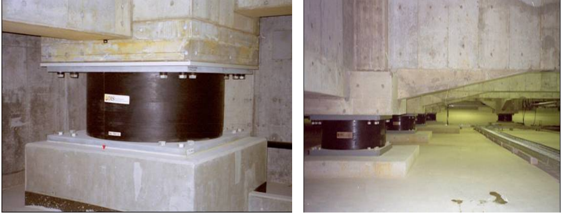
Şekil 3.9. Üst yapı kolon ve kirişlerinin bitmiş hali
