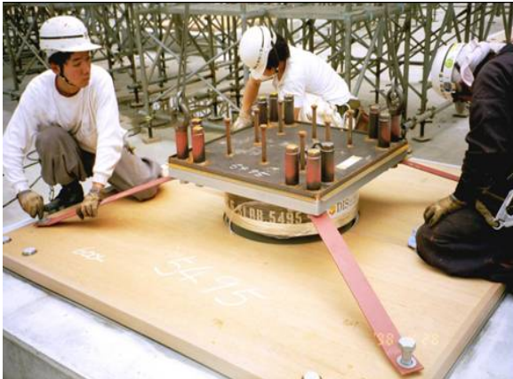
Şekil 3.19. Kayıcı mesnetlerin tamamı yerleştirilmiş ve üst yapı için hazırlıklar devam etmekte
