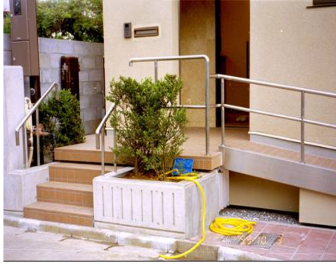
Şekil 3.12. Kauçuk izolatörlerle izolasyonu tamamlanmış yapı
