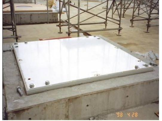
Şekil 3.16. Kauçuk tabakalı kayar mesnet alt plakasının radye temel üzerine yerleştirilmiş hali
