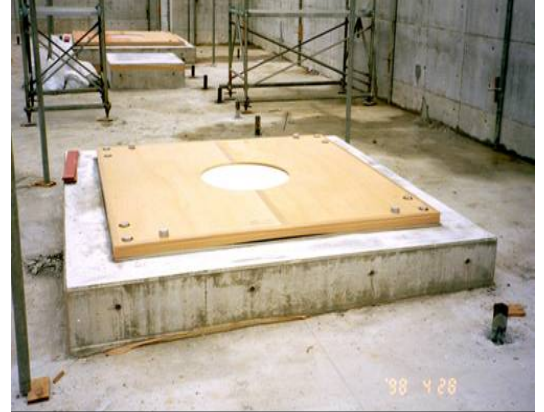
Şekil 3.17. Kauçuk tabakalı kayar mesnedin yerleşeceği kısmın düzenlenmesi
