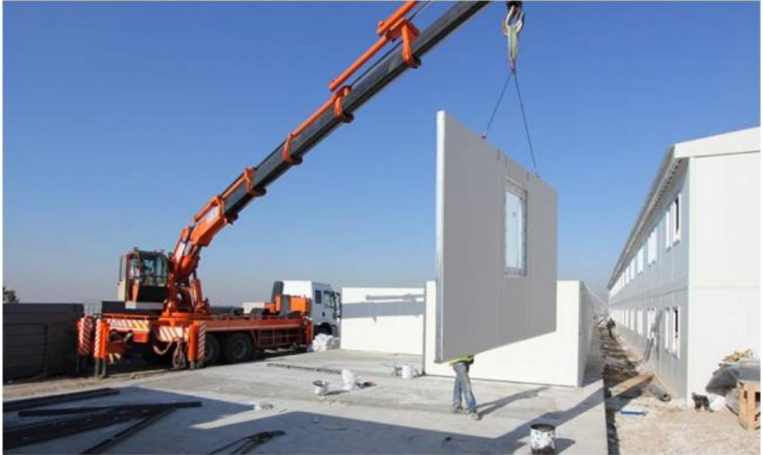
Şekil 2.4 Prefabrik Modüler Yapı Montajı
