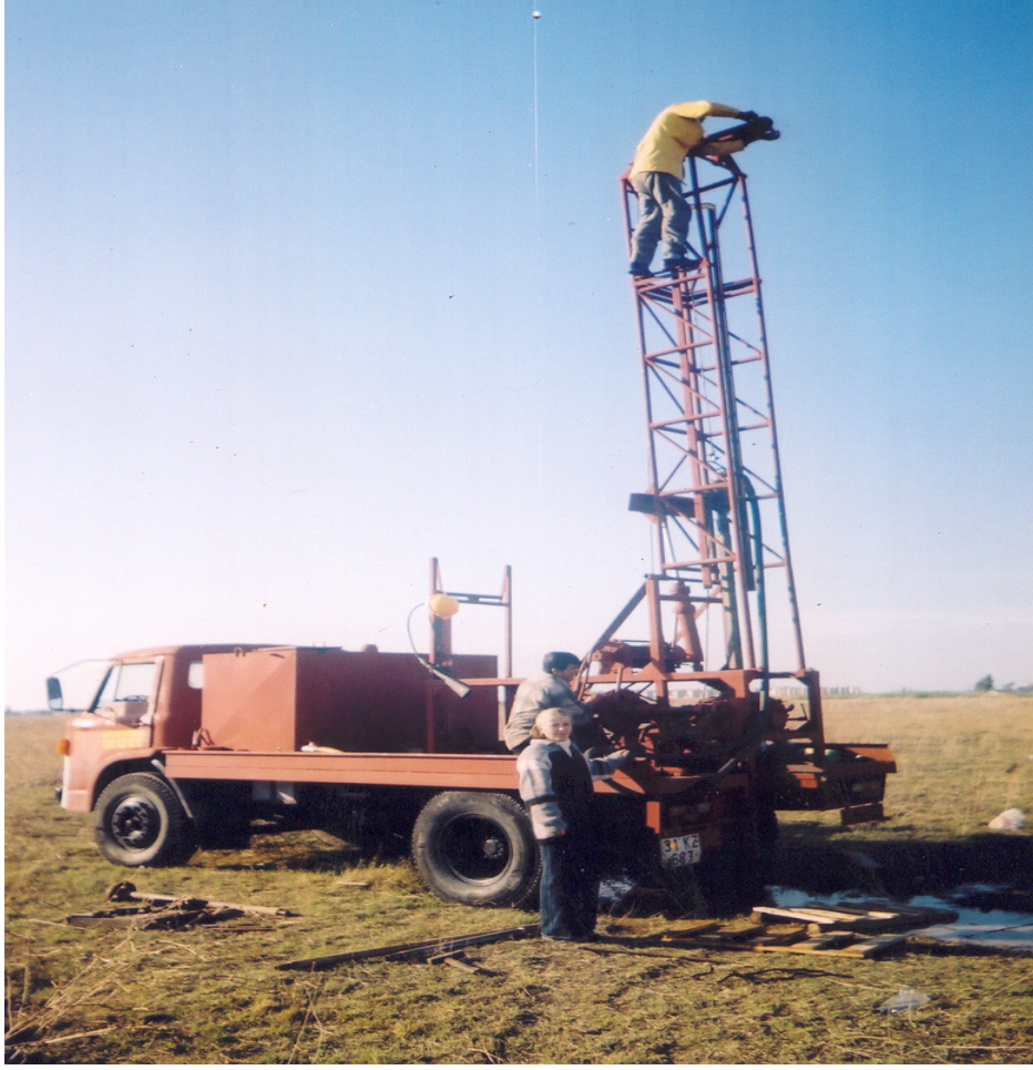
Şekil 3.2. Temel Sondaj Çalışmalarından bir görünüş
