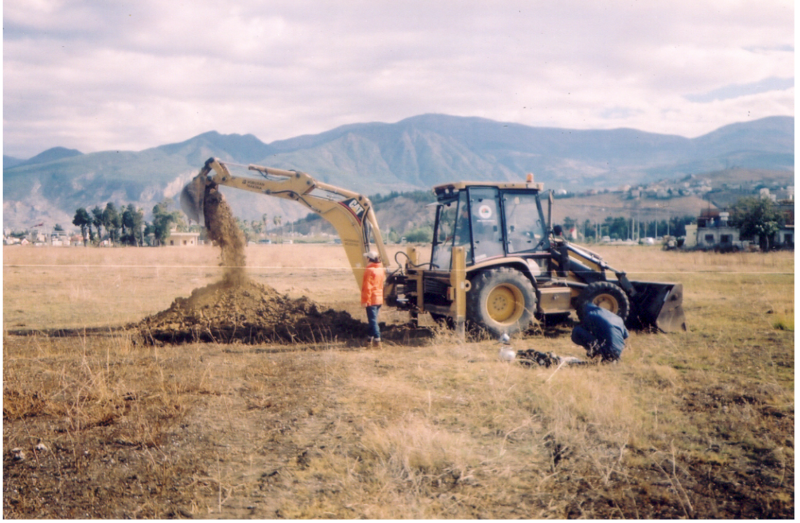
Şekil 3.1. Araştırma Çukurunun açılması
