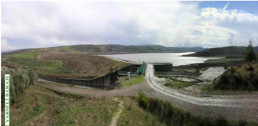
Şekil 4.1. Yarseli Barajı Genel Görünümü
