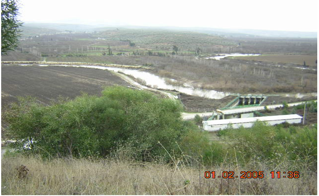
Şekil 4.3. P0 Pompa İstasyonu Genel Görünüşü
