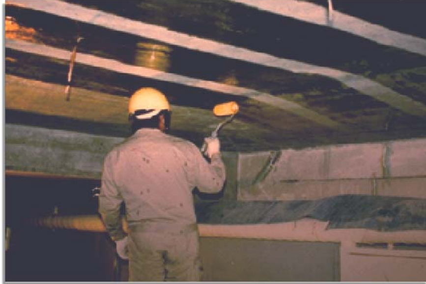
Şekil 4.19. Eğilmeye karşı lifli dokular ile dayanımının artırılması
