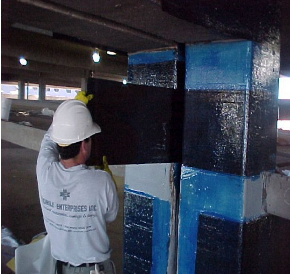
Şekil 4.11. Kolonun lifli polimer (LP) ile sarılması
