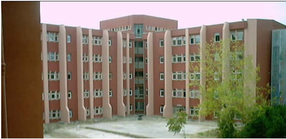
Şekil 4.30. İstanbul Üniv' de perde eklenmesi ile güçlendirme örneği
