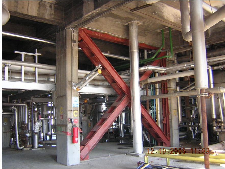
Şekil 4.28. Çerçeve ve boşluklar arasına çelik çerçeveler ve diagonal elemanlar konularak güçlendirme
