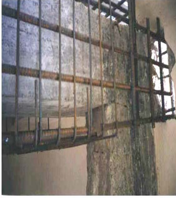
Şekil 4.14. Kiriş mantolanmasında donatılarda sürekliliğin sağlandığı bir kiriş
