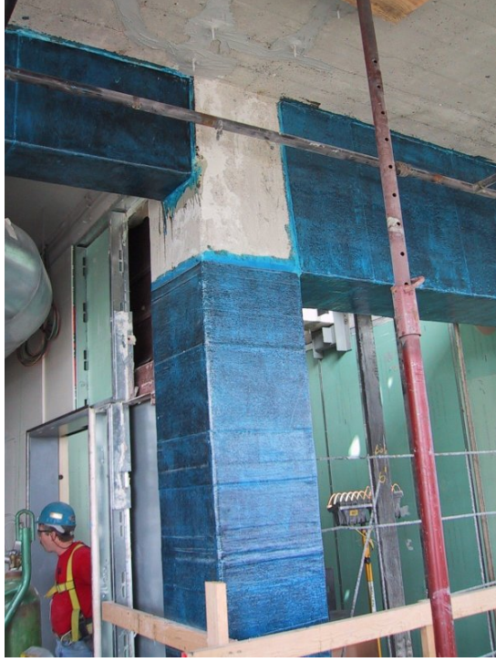
Şekil 4.16. Karbon Lifli Polimerlerle (FRP) kiriş kapasitelerinin artırılması
