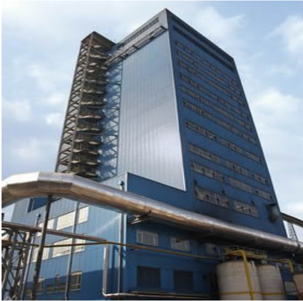
Şekil 4.7. Kömür Enjeksiyon Tesisi
