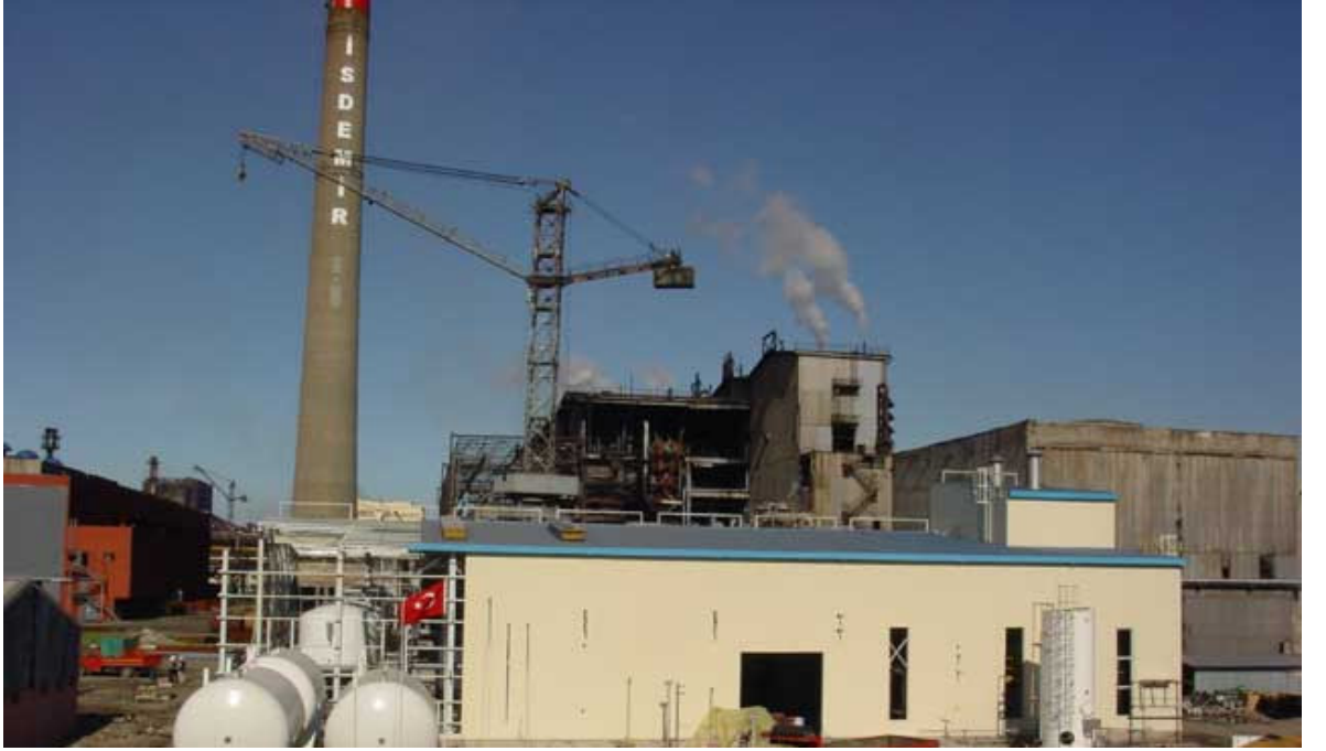
Şekil 4.9. Demineralize Su Tesisi
