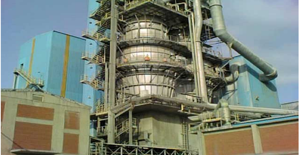
Şekil 4.1. Yeni Teknoloji Kireç Fabrikası
