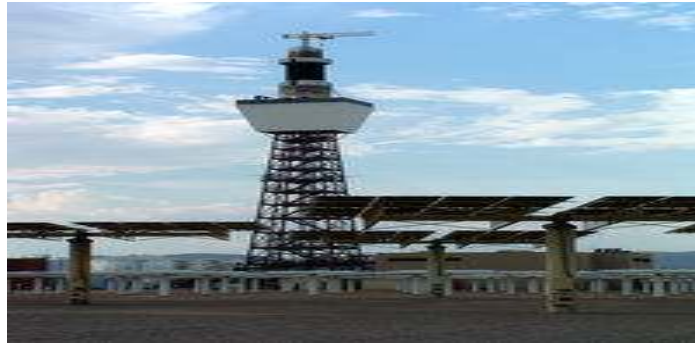
Şekil 3.3. Güneş enerjisi ile çalışan 10 MW kapasiteli termal enerji santrali
