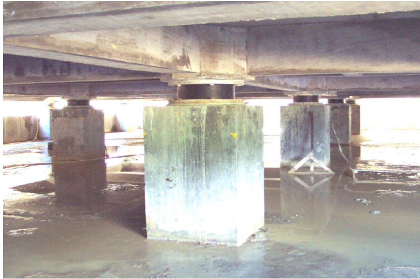
Şekil 3.3. Düşük Sönümlü Kauçuk İzolatör (Naeim ve Kelly, 1999)
