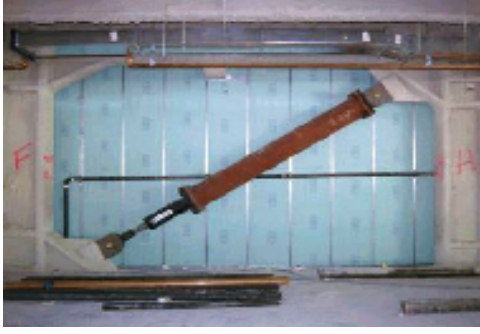
Şekil 3.8. Viskoz Sönümleyici (Kelly, 2001)
