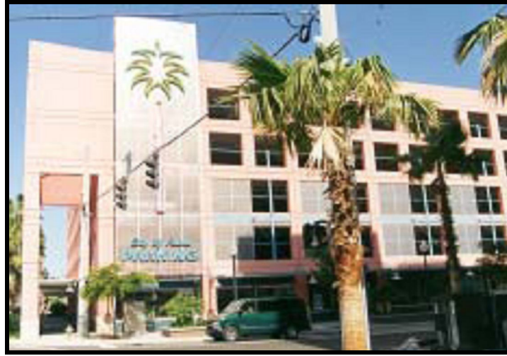
Şekil 4.18. Florida'da Ft. Myers'de Katlı Otopark Örneği (Zemin katlarda perakende satışı içeriyor ve mimari detaylarda araçları perdeler ve pencere görevi görür) (Anonymous, 2007a)
