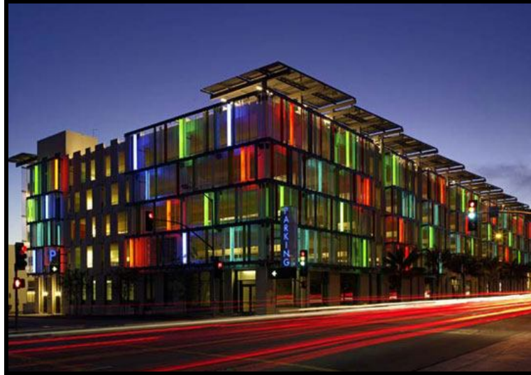
Şekil 4.20. California’da Santa Monica Şehir Kompleksi Otopark Yapısı (Anonymous, 2007b)
