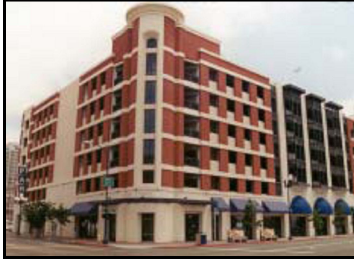
Şekil 4.19. California San Diego’da Yer Alan Otopark Yapısı (Zemin katlarda perakende satışı olarak ayrılan otopark yapısı, üst katlarda pencerelerle benzer olarak ayrıntılandırılır. Bu da çevredeki binalarla harmanlanmasını sağlar.) (Anonymous, 2007a)
