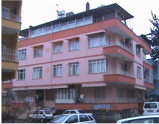
Şekil 4.14. A-2 binasının ön cepheden fotoğrafı
