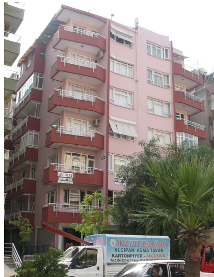
Şekil 4.56. B-3 binasının ön cepheden fotoğrafı
