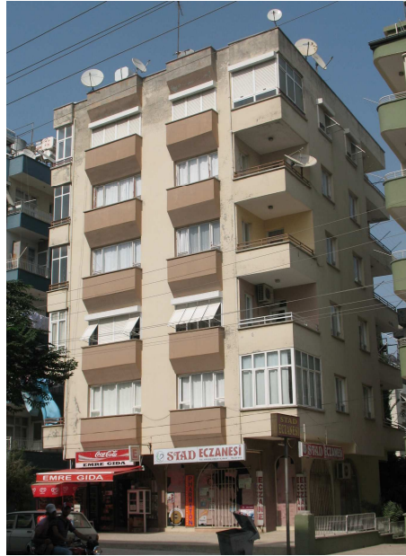
Şekil 4.28. A-4 binasının ön cepheden fotoğrafı
