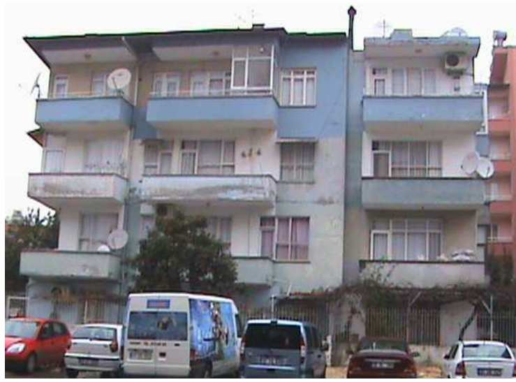
Şekil 4.6. A-1 binasının ön cepheden fotoğrafı
