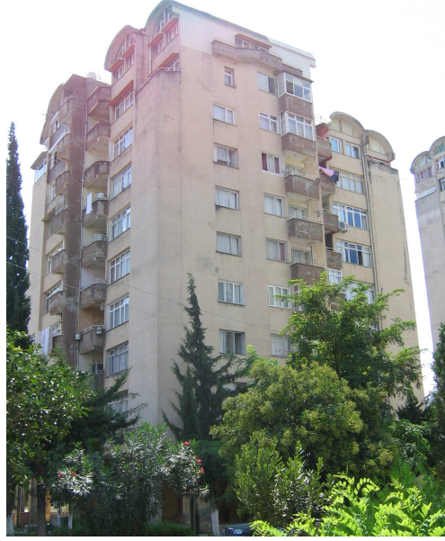
Şekil 4.70. C-2 binasının ön cepheden fotoğrafı
