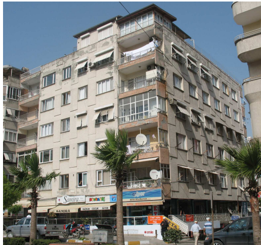
Şekil 4.49. B-2 binasının ön cepheden fotoğrafı
