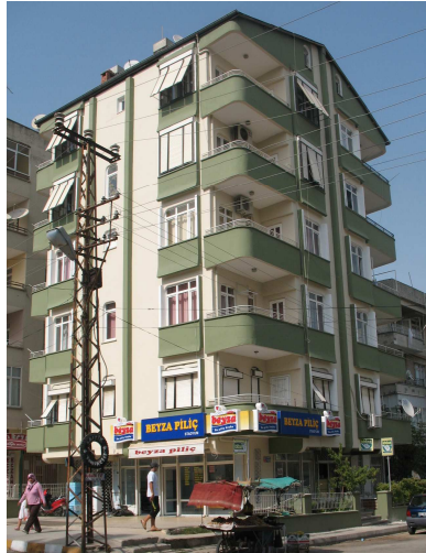
Şekil 4.35. A-5 binasının ön cepheden fotoğrafı
