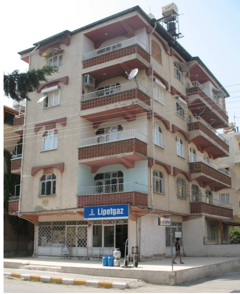
Şekil 4.21. A-3 binasının ön cepheden fotoğrafı
