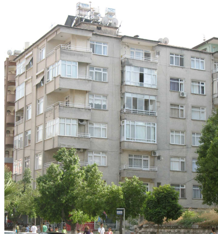
Şekil 4.42. B-1 binasının ön cepheden fotoğrafı
