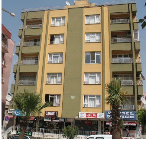
Şekil 4.63. C-1 binasının ön cepheden fotoğrafı
