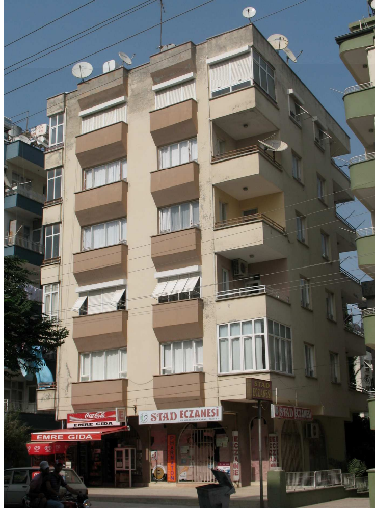
Şekil 4.32. Nizamettin Tohma Apartmanı'nın görüntüsü
