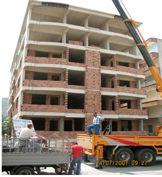
Şekil 4.1. Ayhan Girişken Apartmanı'nın ön görüntüsü
