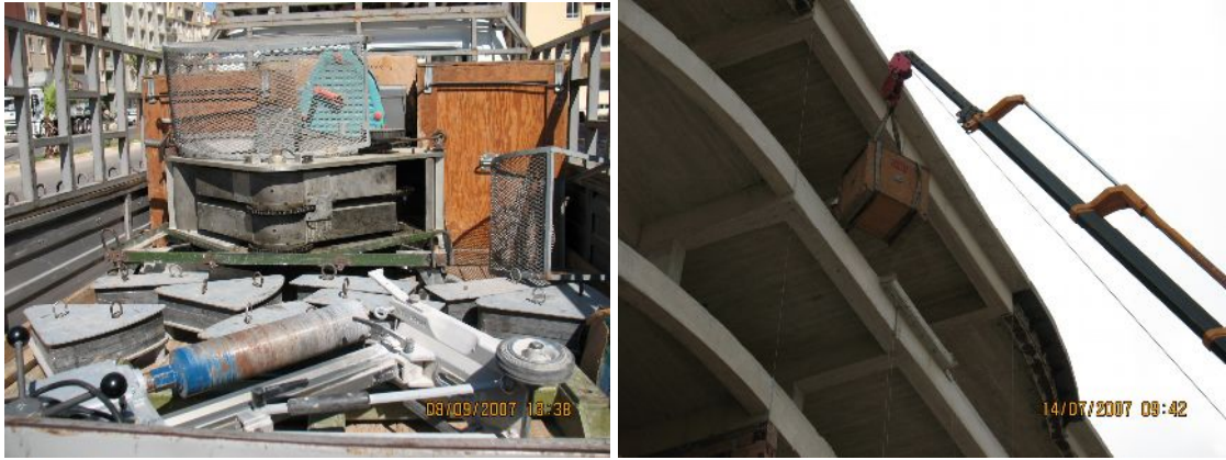
Şekil 3.13 Cihazların getirilmesi ve yapıya taşınması
