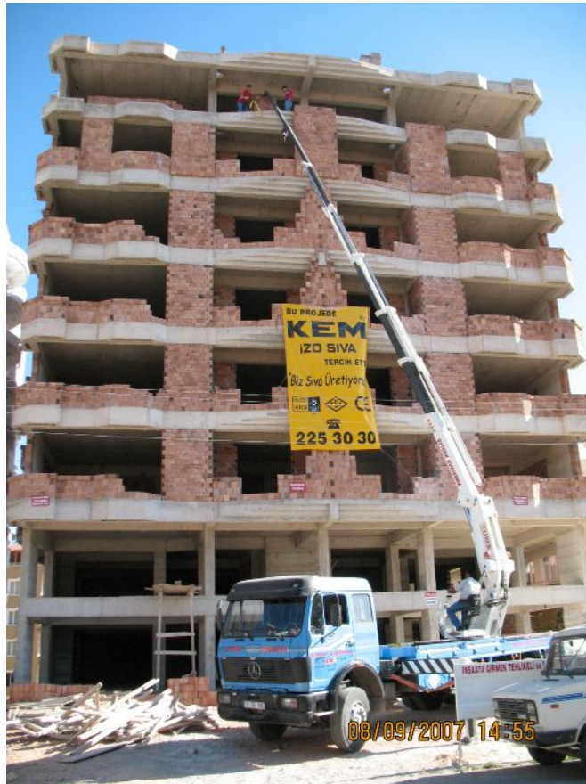
Şekil 5.1 Mehmet Ali YÜKSEL binası
