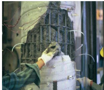
Şekil 3.23 Kolonun Betonarme ile mantolanma uygulaması
