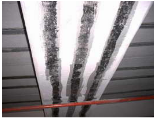
Şekil 3.35 Karbon lifli şeritlerle kiriş eğilme kapasitelerinin artırılması
