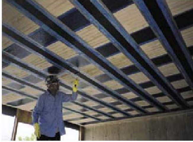
Şekil 3.34 FRP ile eğilmeye karşı dayanımın artırılması uygulaması
