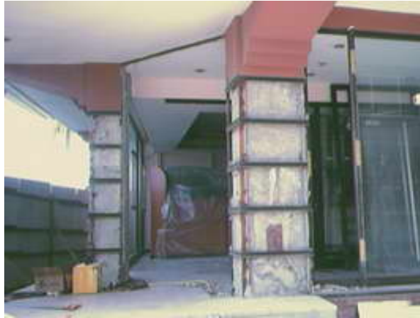
Şekil 3.21 Çelik Mantolama ile Yapının Güçlendirilmesi
