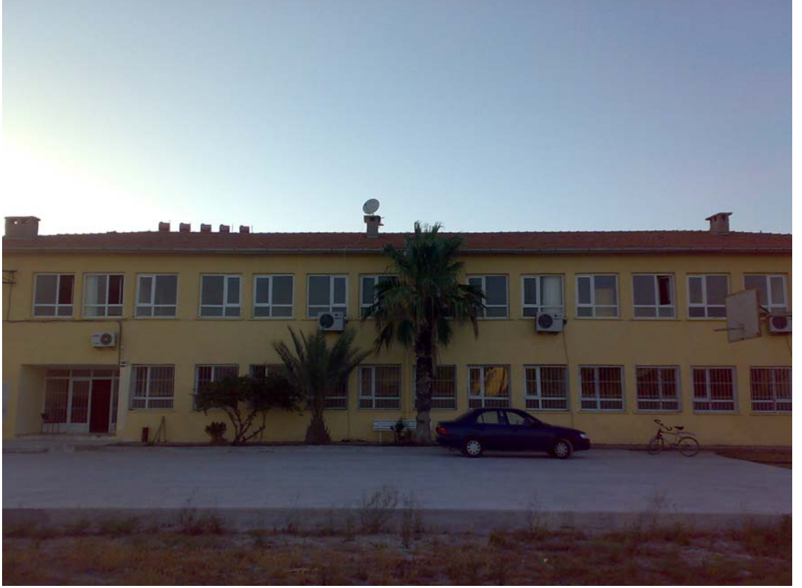
Şekil 4.1. Ulubatlı Hasan İlköğretim Okulu'na ait ön cepheden bir görünüm
