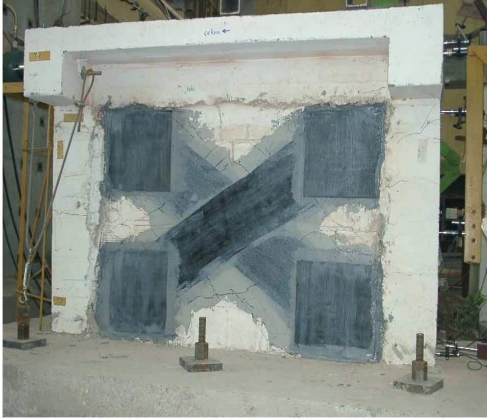
Şekil 3.13 Dolgu Duvarlarının Lifli Polimerler ile Güçlendirilmesi
