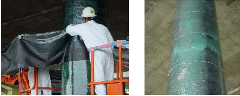
Şekil 3.25 Kolon güçlendirmesinde lifli polimer (LP) ile sargı
