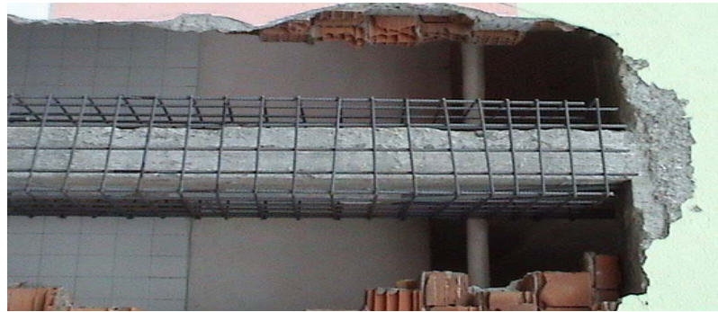
Şekil 3.32 Kiriş mantolama uygulaması yapılan bir kiriş
