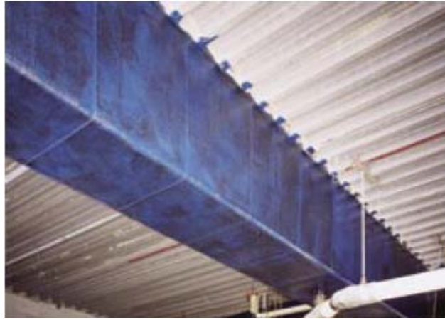
Şekil 3.33 Karbon Lifli Polimerlerle (FRP) kiriş kapasitelerinin arttırılması
