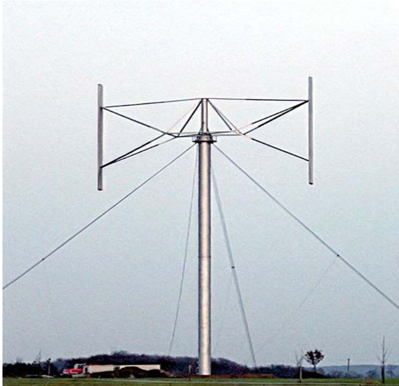
Şekil 3.6. H-Darrieus rüzgâr türbini
