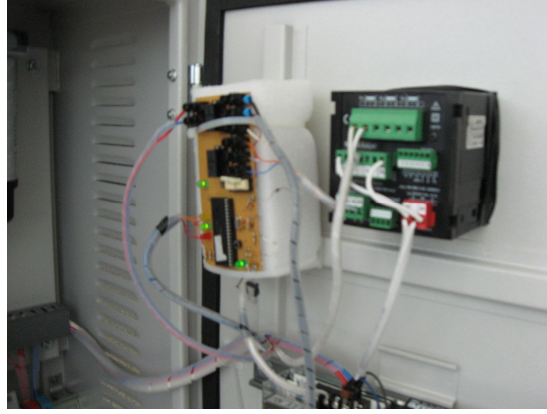
Şekil 3.17 MPR60 cihazının panodaki bağlantısı
