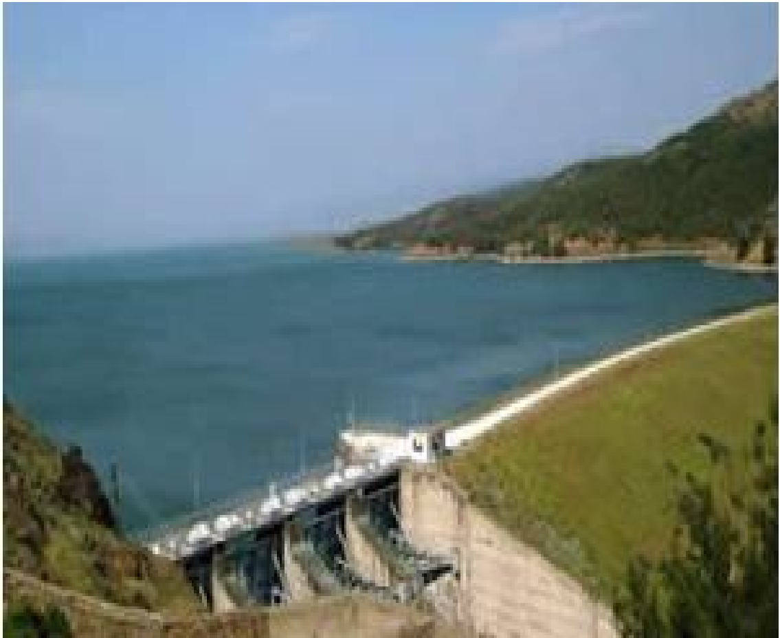
Şekil 4.1. Tahtaköprü Barajı Genel Görünümü
