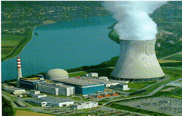
ŞEKİL 3.4. NÜKLEER ENERJİ SANTRALİ VE DOĞAL ÇEKİŞLİ SOĞUTMA KULESİ
