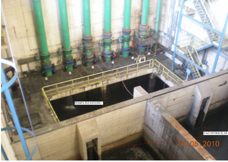
ŞEKİL 5.7. TUFAL ÇUKURU YAĞ SIYIRICALAR VE POMPA İSTASYONU
