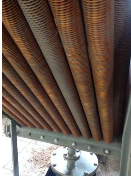
Şekil 3. 13. Gaz soğutma ünitesi genel ve alttan (serpantinli borular) görünüşleri
