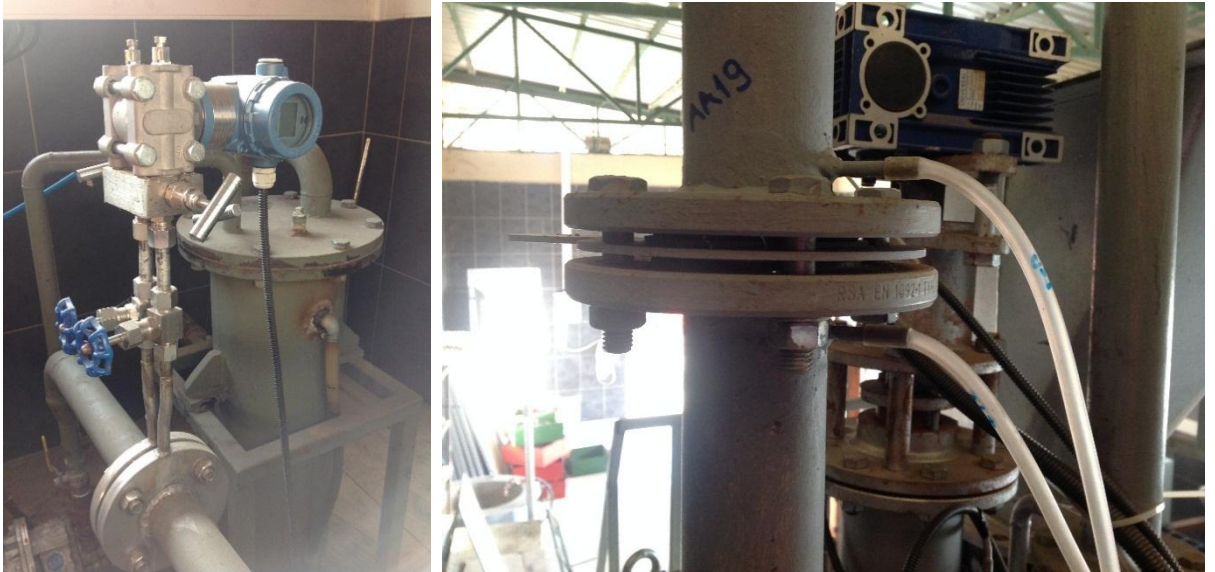
Şekil 3. 30. Sentez gazı çıkış ve hava giriş debilerinin ölçülmesi için orifis debimetreler
