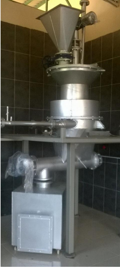
Şekil 3. 11. Gazlaştırıcı reaktör montajı
