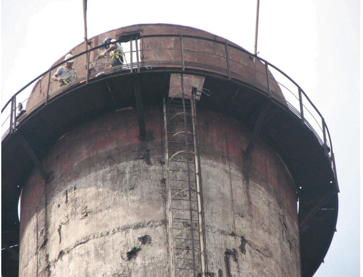
Şekil 4.12 Üst Kotlarda Sensör Yerleşimleri
