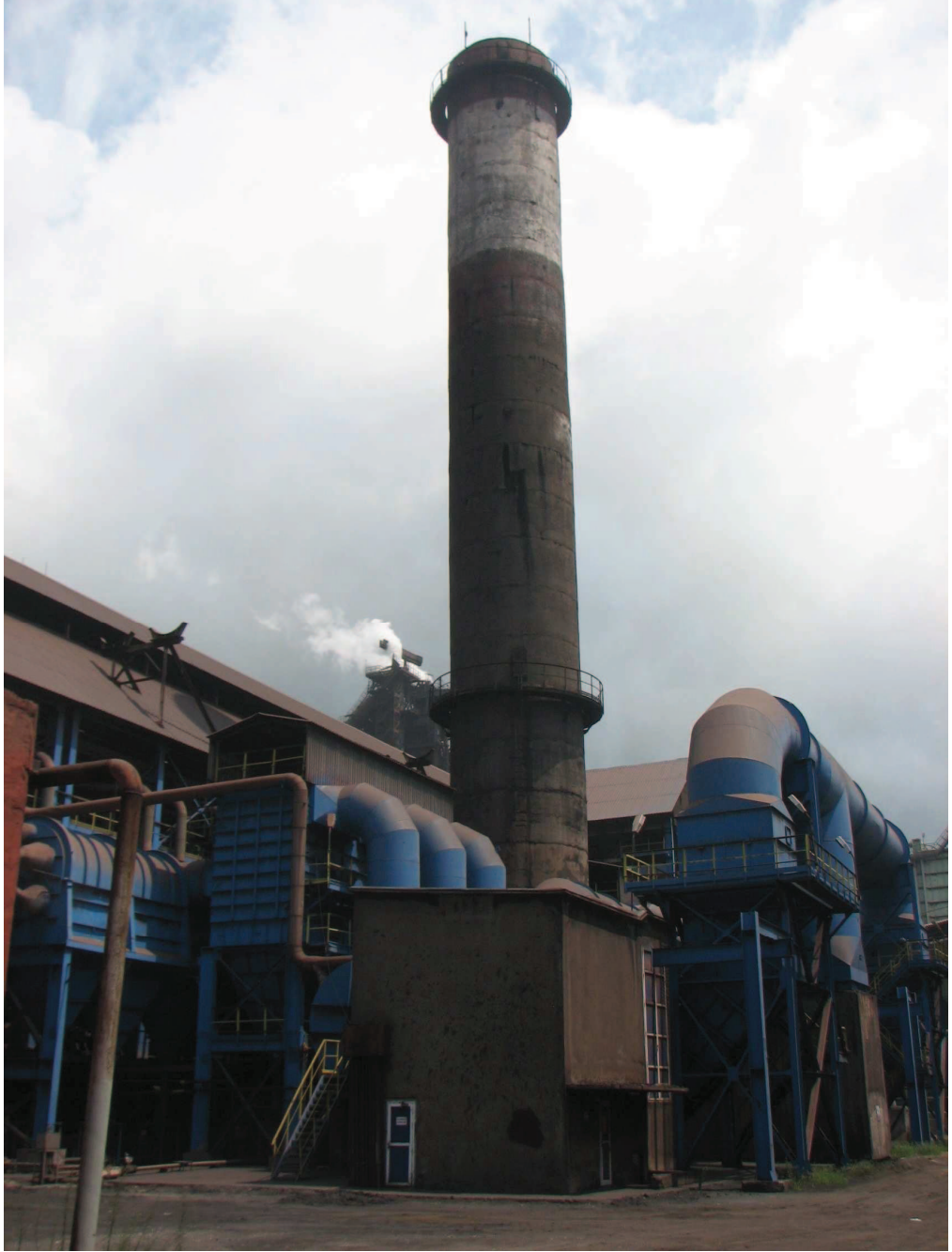
Şekil 1.1 Baca Genel Görünüşü (Kuzey Cephe)
