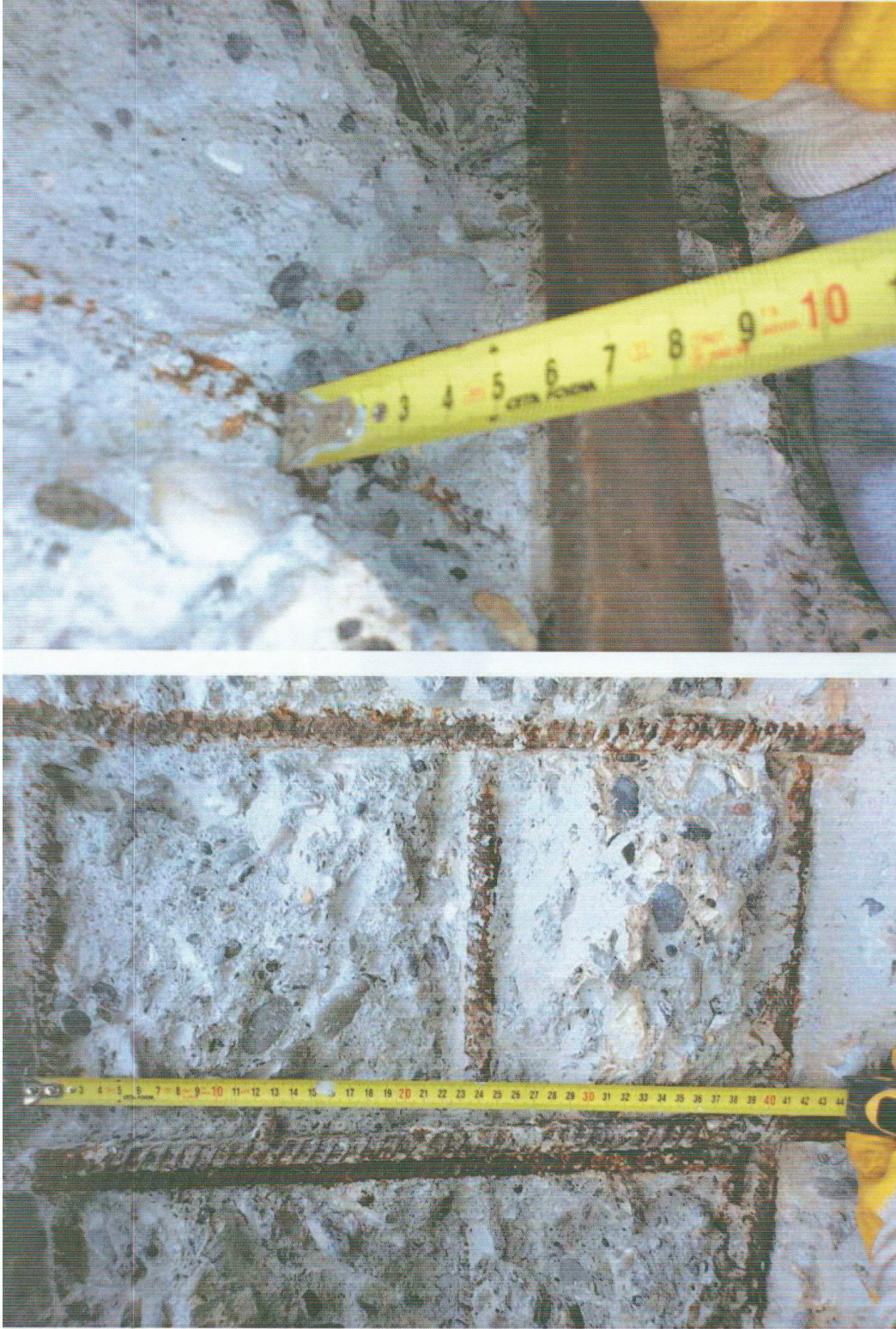
Şekil 4.21 Baca Pas Payı Ölçümleri
