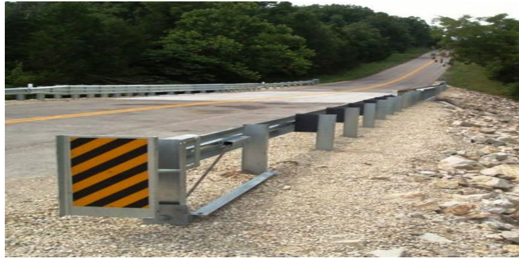
Şekil 1.1. Karayolu Çelik Otokorkulukları ve Yapı Elemanları
