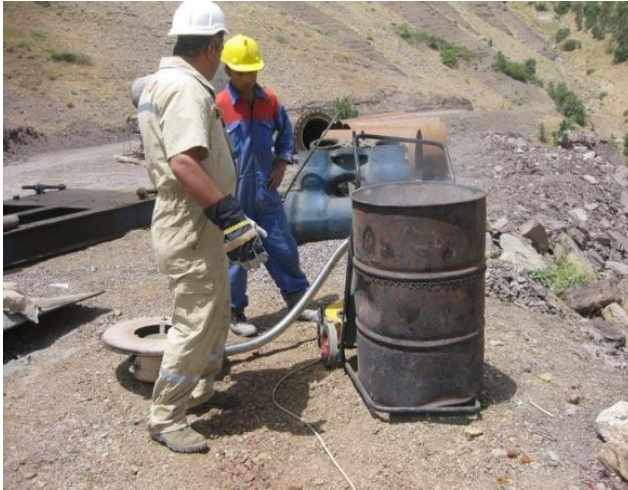
Şekil 4.35 Petrol/Doğalgaz sondaj çalışma alanında Mobil Atık Yakma Fırını
