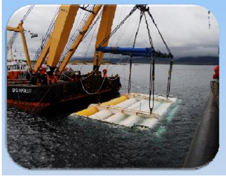
Şekil 2.49. Oyster denize bırakılıyor (The Development of Oyster, 2009)
