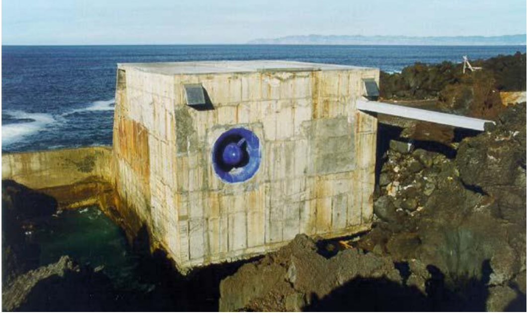
Şekil 2.27. Kıyı tipi bir DEK sisteminin arkadan görünüşü (Cruz, 2008)
