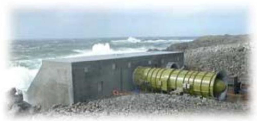
Şekil 2.37. Salyangoz (Limpet) modeline ait gerçek görünüm (Heath, 2008)
