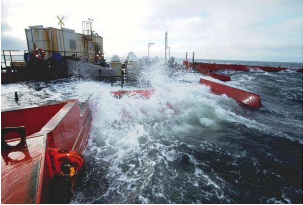
Şekil 2. 73. Wave Dragon dalgalardan enerji elde ediyor (Anonymous, 2010h)
