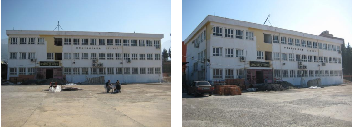
Şekil 4.20. Denizciler Lisesi binasında güçlendirme çalışmaları
