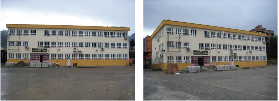
Şekil 4.21. Güçlendirme Sonrası Denizciler Lisesi binasının görüşleri
