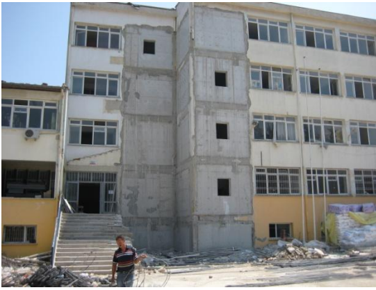
Şekil 4.27. Ticaret Lisesi binasının güçlendirme aşamaları
