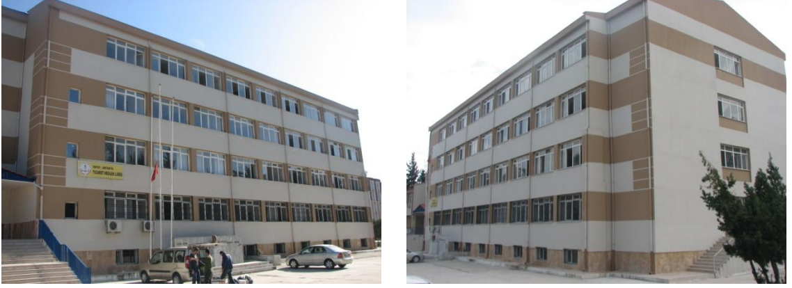
Şekil 4.28. Güçlendirme Sonrası Ticaret Lisesi binasının farklı yönlerden görüşleri
