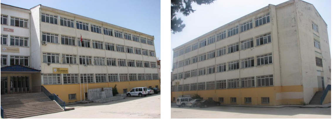
Şekil 4.3. Ticaret Lisesi binasının farklı yönlerden görüntüşleri
