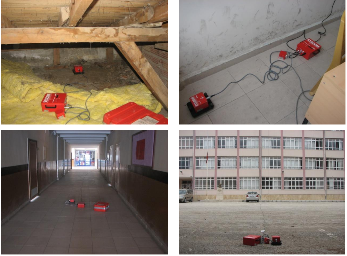
Şekil 4.37. Güçlendirme Sonrası Hüseyin Özbuğday Lisesi binasının ölçümünde kullanılan sensörler
