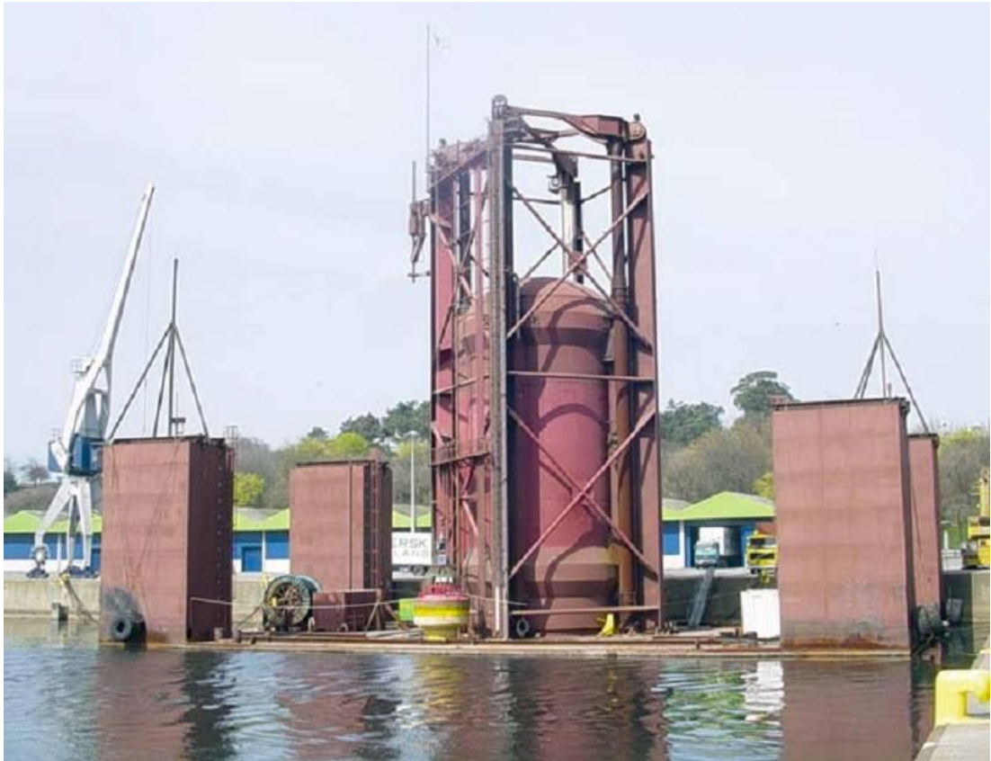
Şekil 2.97. 2MW'lık pilot AWS uygulaması 2004 yılında Leixões limanında çekilen bir resmi
