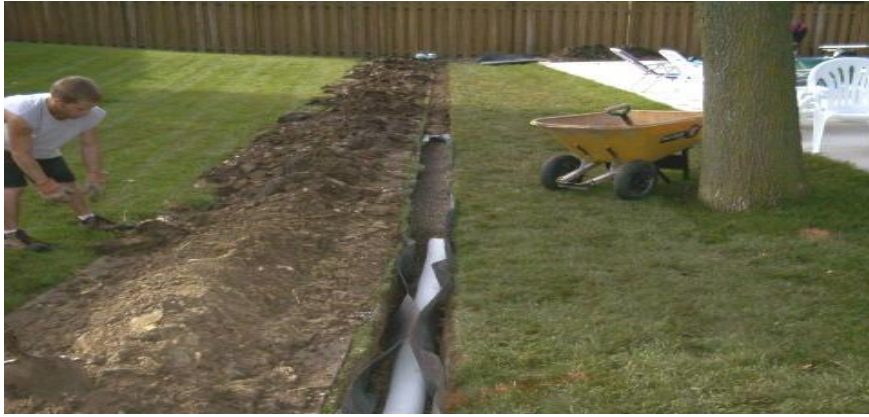
Şekil 4.16. Kapalı Drenaj Uygulaması
