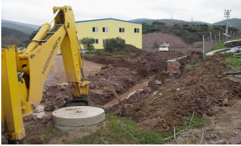
Şekil 4.29. Bina Etrafı Drenajının Uygulanması
