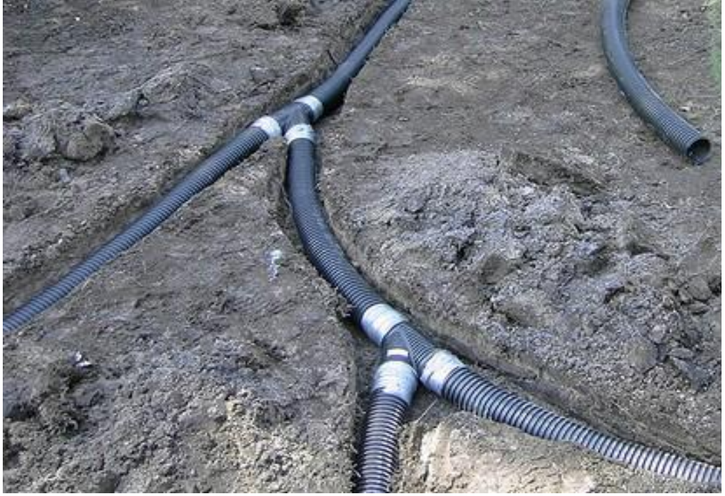
Şekil 4.17. Drenaj Boru Bağlantısı
