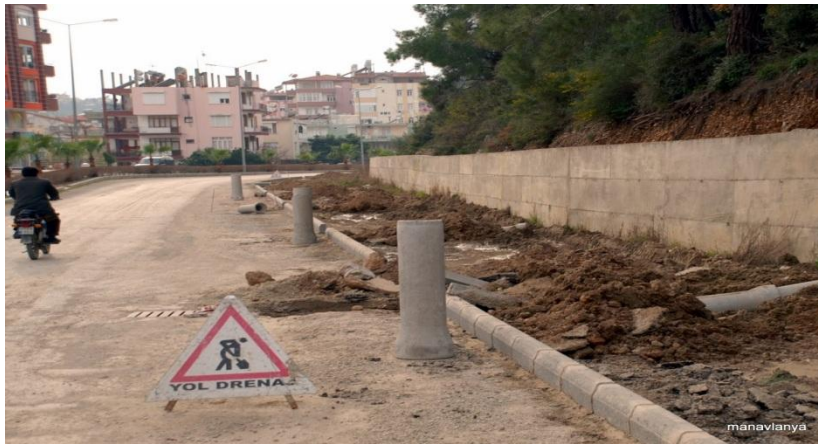
Şekil 4.22. Yüzey altı Drenajı
