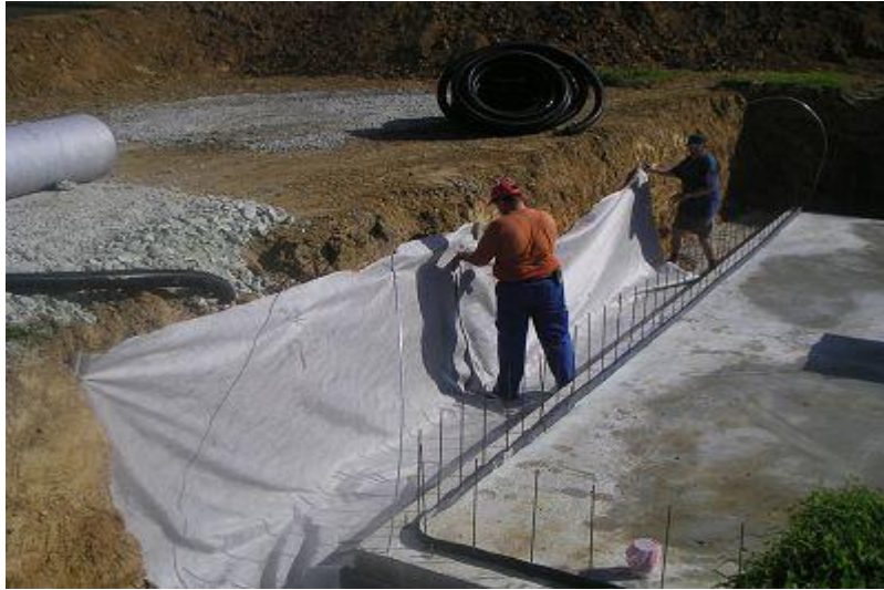
Şekil 4.28. Yapı Dış Drenajı
