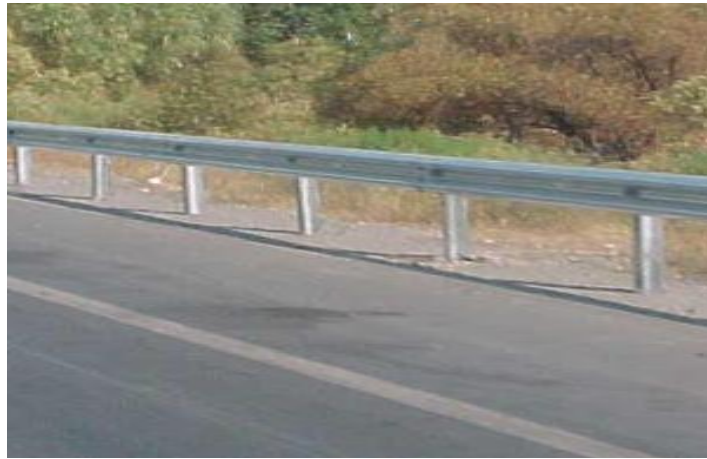
Şekil 1.18. Basit otokorkuluk (2,00 m dikme aralıklı) (URL-5, 2010)
