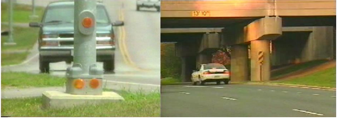
Şekil 1.13. Aydınlatma direği ve yol platformuna bitişik köprü kolonu (Atahan, 2001)
