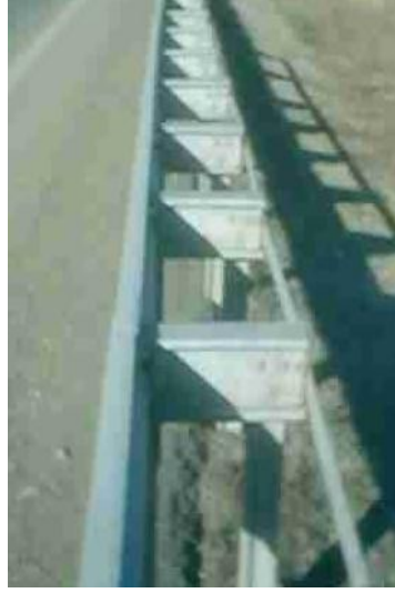
Şekil 1.20. Basit mesafeli otokorkuluk (2,00 m.dikme aralıklı) (URL-8, 2010)
