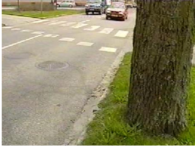
Şekil 1.12. Yol kenarındaki tek ağaç örneği (Atahan, 2001)
