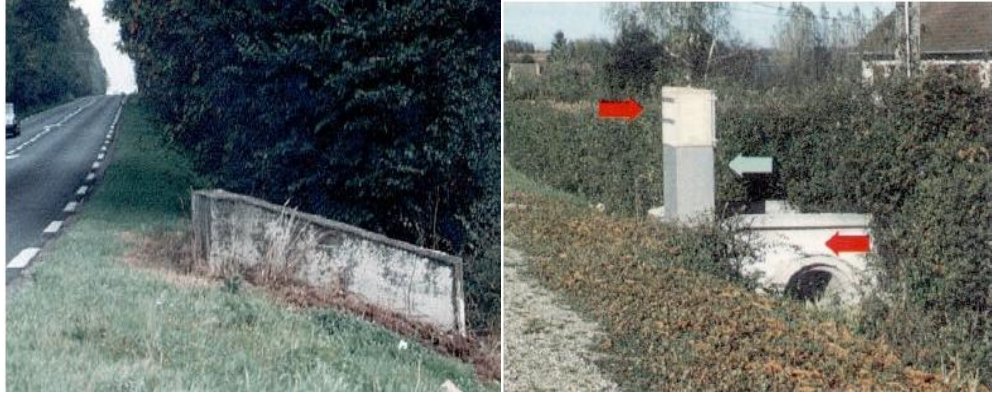
Şekil 1.16. Menfez duvarları ve drenaj boruları (Atahan, 2001)
