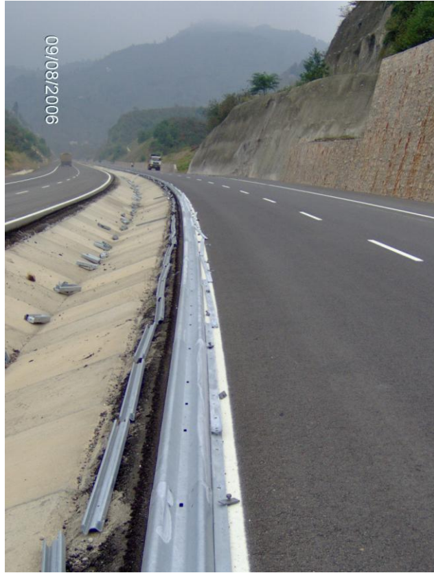
Şekil 1.5. Karayoluna paralel açılmış kanallar (Dilberoğlu, 2011)
