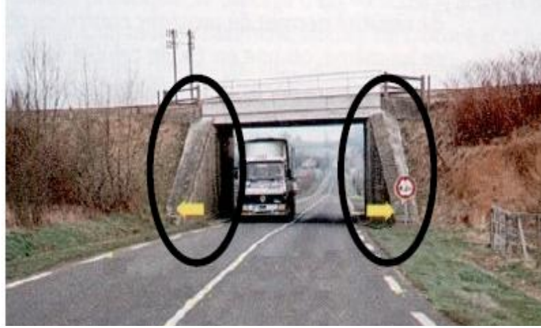
Şekil 1.15. Korumasız köprü duvarları (Atahan, 2001)
