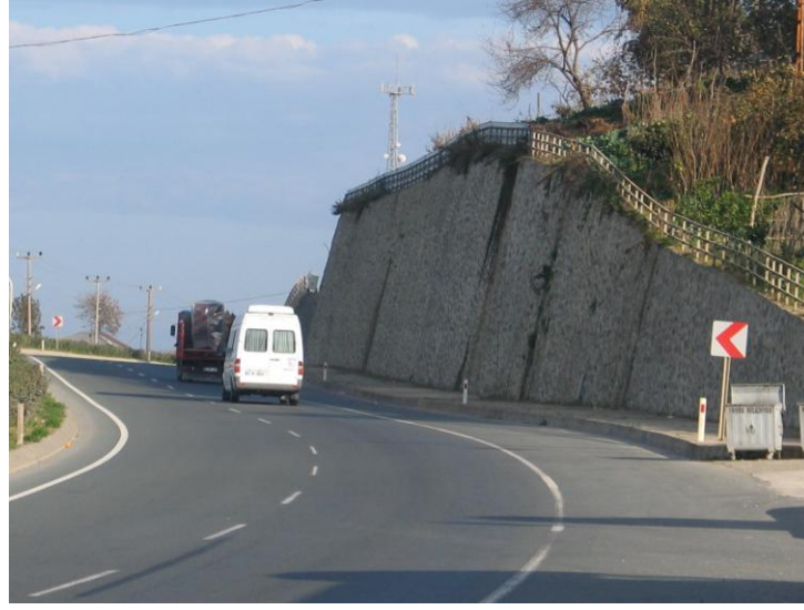
Şekil 1.11. İstinat duvarları (Yomra/Trabzon çıkış kavşağı yanı) (Dİlberoğlu, 2011)
