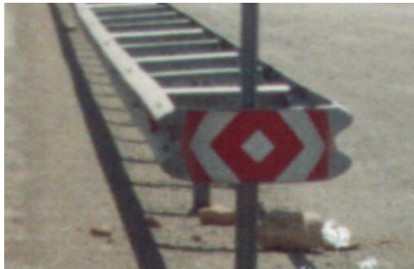
Şekil 1.23. Çift tarafli mesafeli otokorkuluk (2,00 m dikme aralıklı) (Dilberođlu, 2011)
