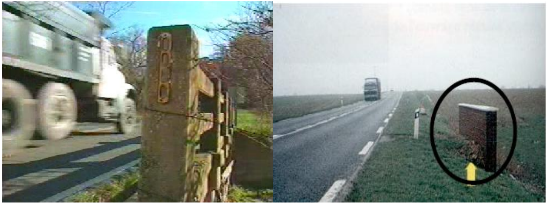
Şekil 1.14. Korunmamış köprü korkulukları (Atahan, 2001)
