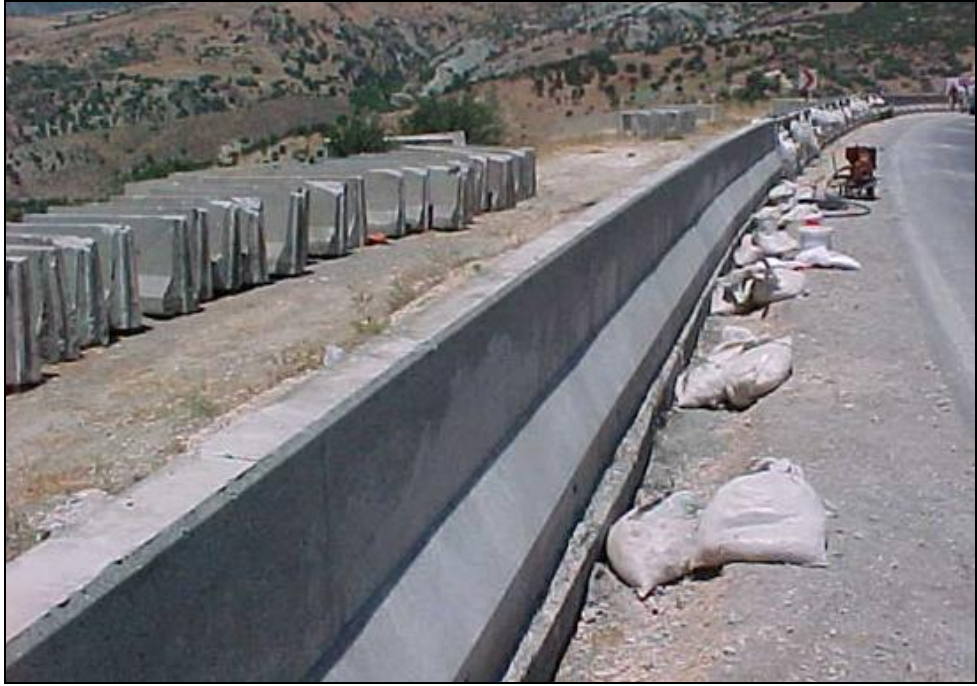
Şekil 1.27. Beton otokorkuluklar (Atahan, 2001)
