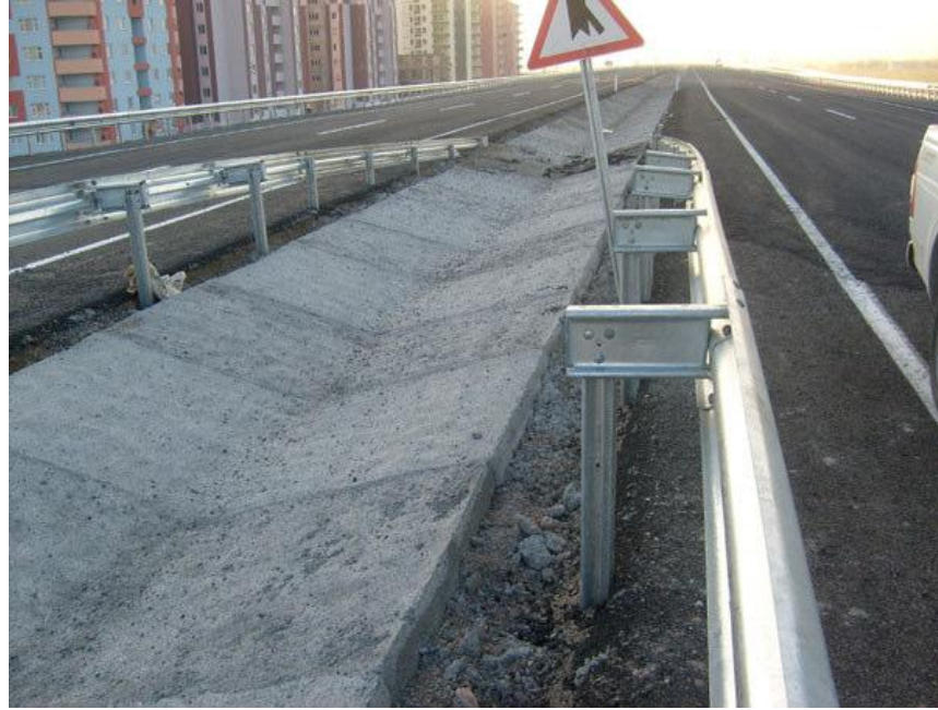
Şekil 1.1. Refüjde bulunan inşa aşamasındaki üçgen kesitli drenaj kanalı
