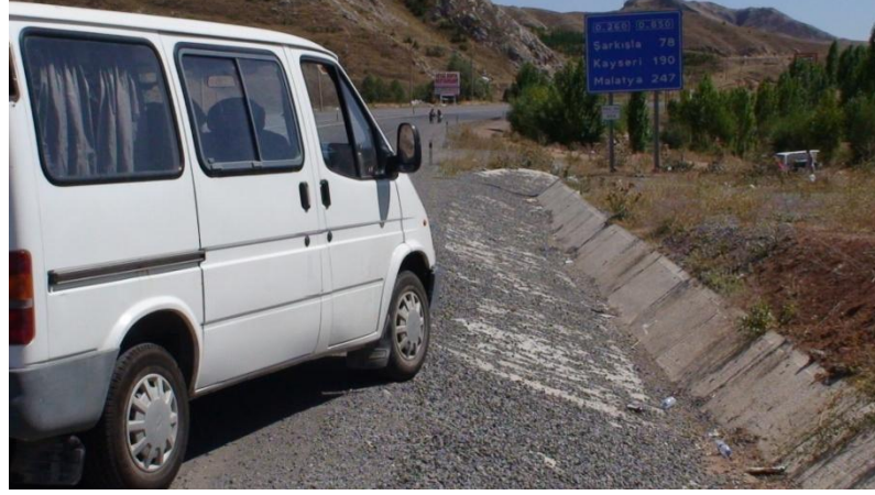
Şekil 1.2. Yol platformu yakınındaki üçgen kesitli yağmur drenaj kanalı ve yoldan çıkan araçlar için oluşturabileceği tehlike
