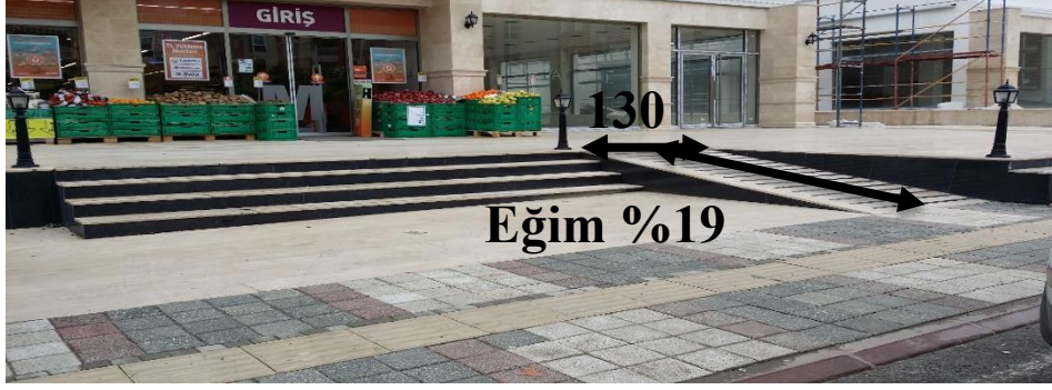
j.)Hürriyet Mah. Müjgan Kalelioğlu Sok. Migros önü rampası
