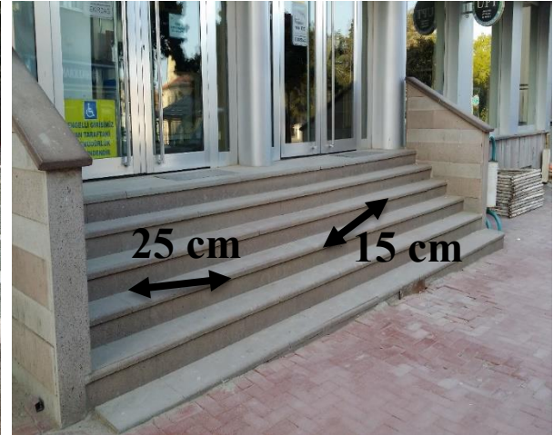
b.)Ertuğrul Mah. PTT binası girişi merdiveni
