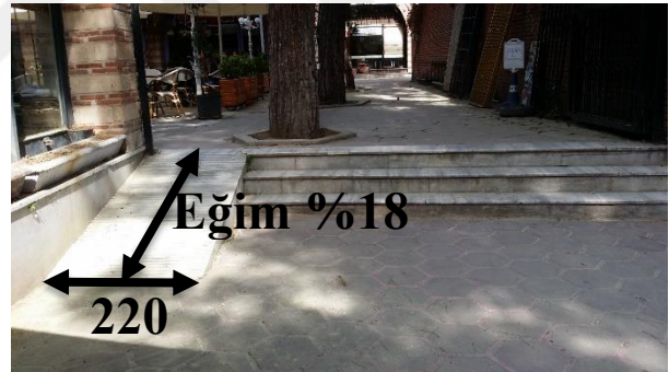
d.)Ertuğrul Mah. Rüstempaşa Çarşısı girişi rampası
