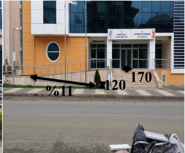
d)Hürriyet Mahallesi Müjgan Kalelioğlu Sok. Tapu Müdürlüğü bina girişi
