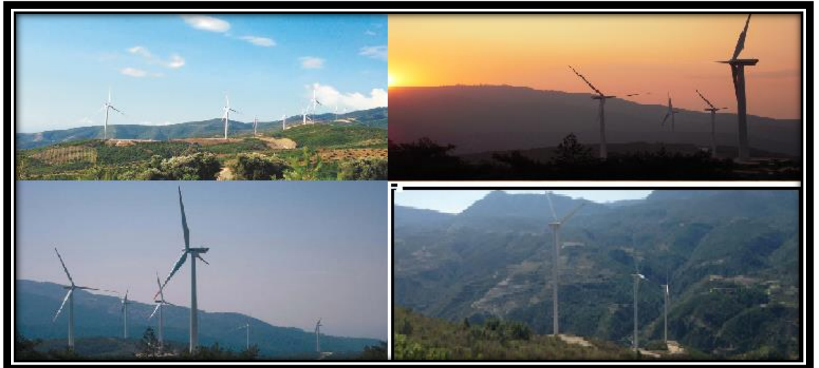
Şekil 1.13. Hatay bölgesindeki rüzgar enerji santralleri ( www.tureb.com.tr , 2014)
