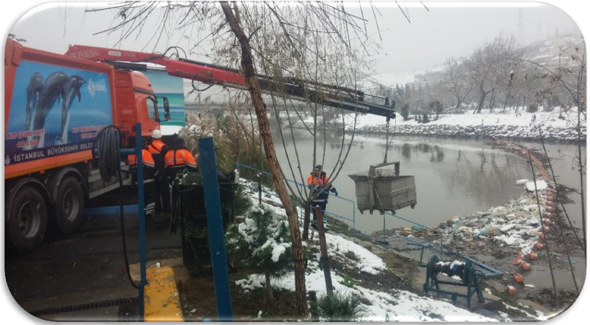
Resim 2.29. Vinçli kamyon ile dere bariyerlerinden atıkların alınması (İSTAÇ 2016)
