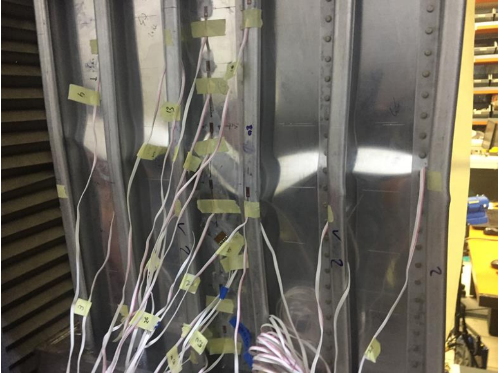
Şekil 5.9 Çökme Sonucunda Oluşan Bölgesel Burkulmalar – Arka Görünüm
