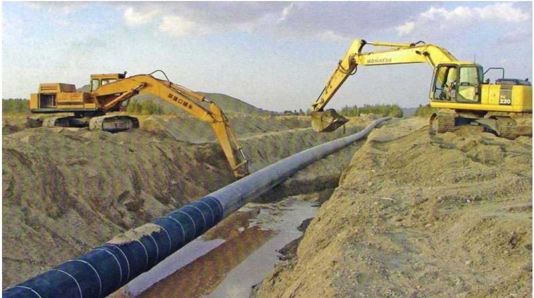
Fotoğraf.8 Doğalgaz Hattı Döşeme Çalışmaları (Ejebşir)
