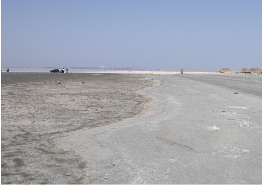
Foto 6.6: Urmiye Gölü'nün aylar arasındaki seviye farklılığı kıyılarda görülebilmektedir. Arka planda yapımı devam eden yolun orta kesimindeki köprü görülmektedir.
