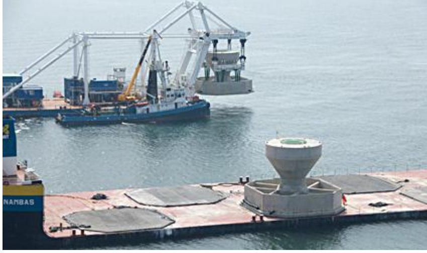
Şekil 3.2 Yerçekimi merkezli temelin dubalarla taşınması ve vinçle yerleştirilmesi[24]
