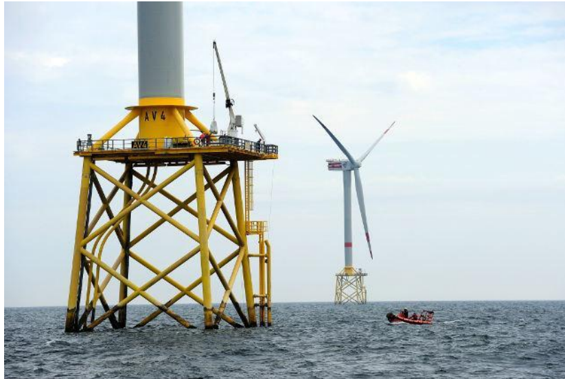
Şekil 3.6 Ceket tipi temel üzerine kurulmuş bir deniz üstü rüzgâr türbini[29]
