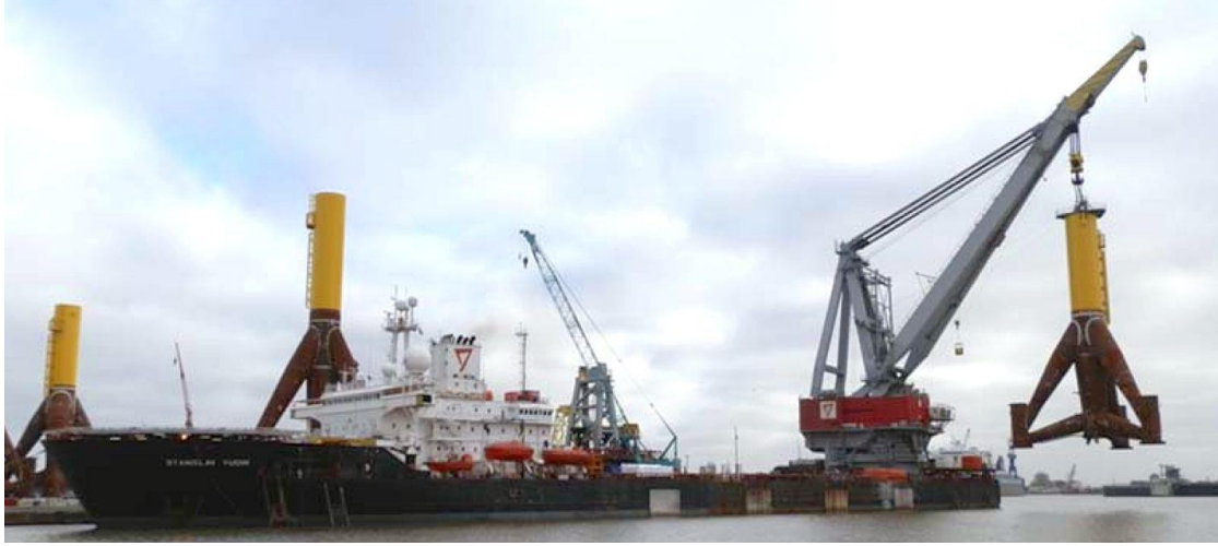
Şekil 3.5 Üç ayak temel üst yapısının vinçle montaj yapılacak alana indirilmesi[28].
